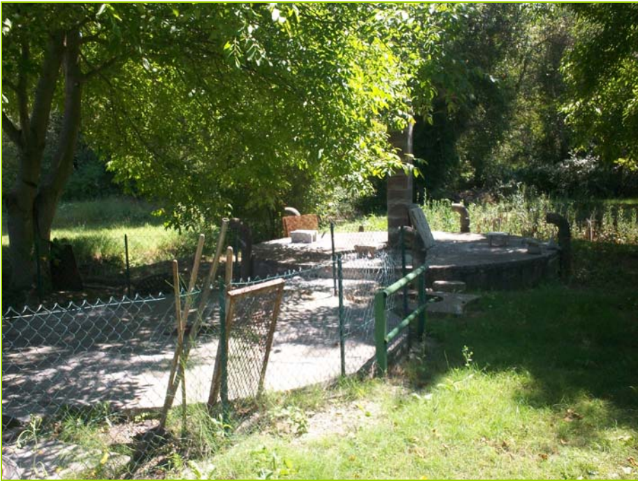
Illustration 1 : La station d'épuration de St Julien d'Asse
