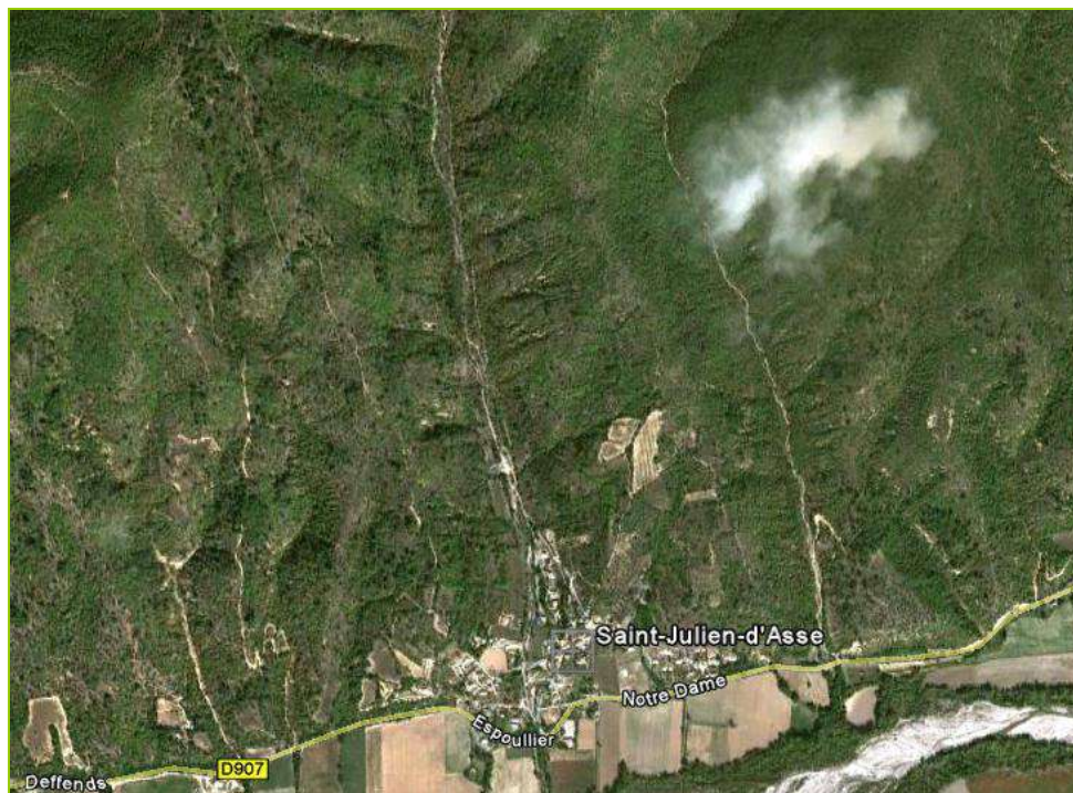
Figure 17 : Vue aérienne du bassin versant du village de Saint Julien d'Asse
