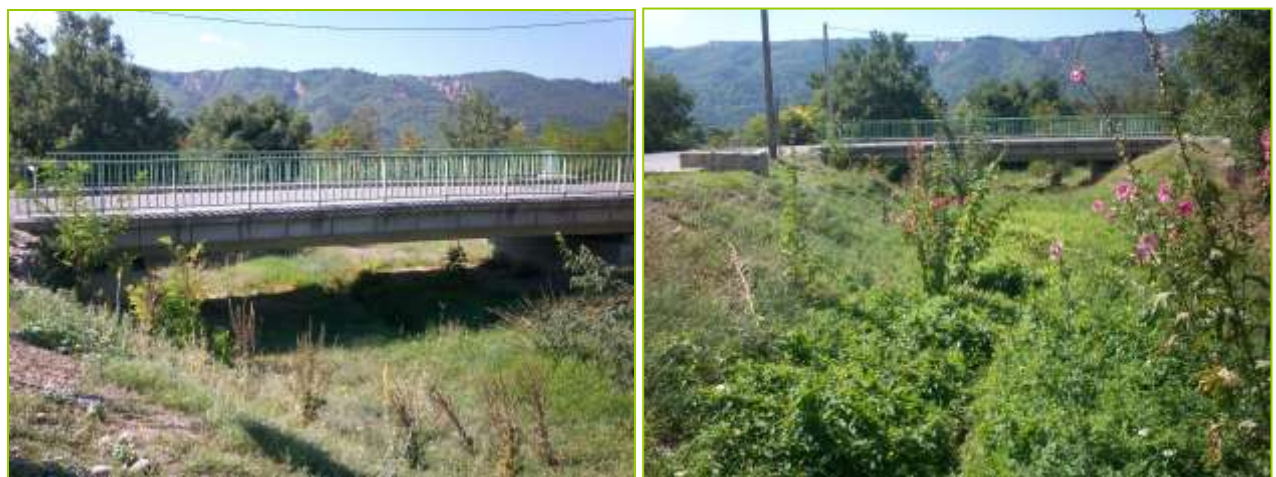
Figure 22 : Pont de la RD 907
