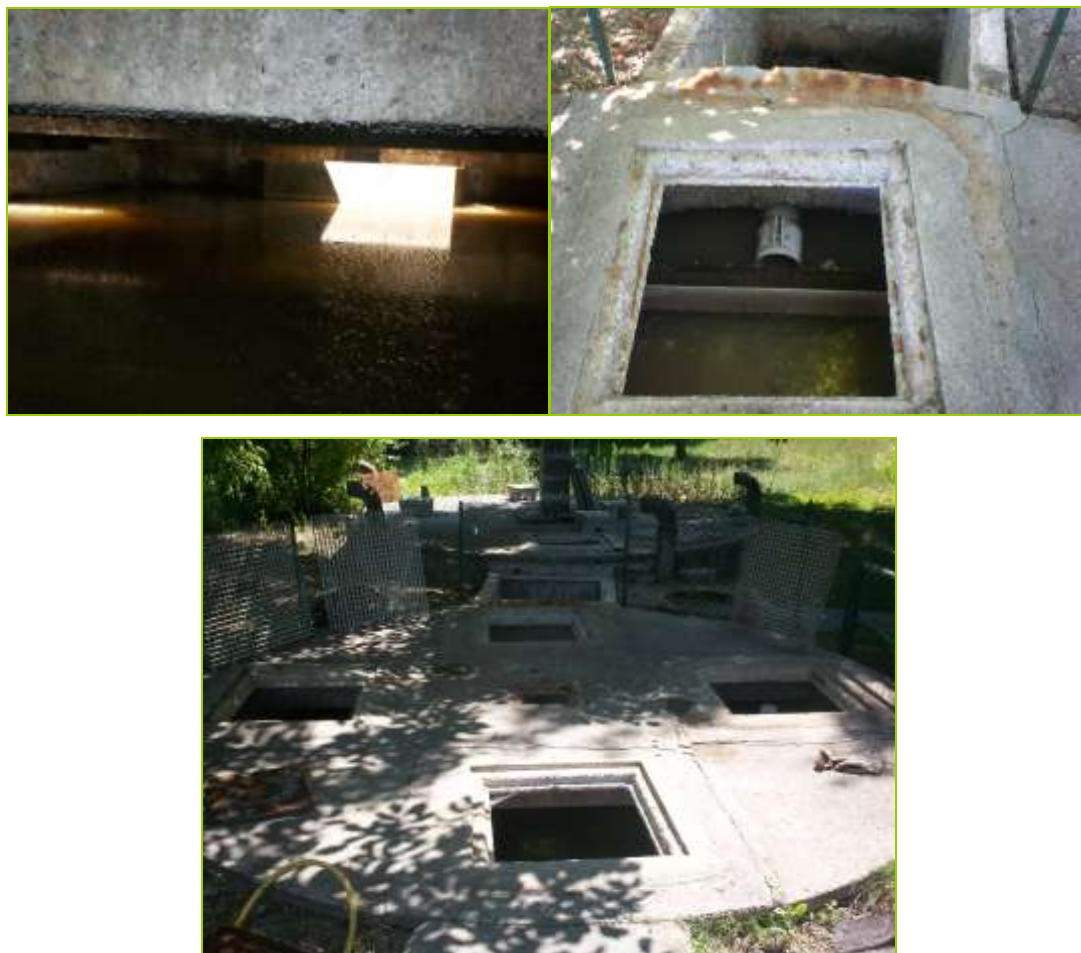
Illustration 3 : Le décanteur-digesteur
