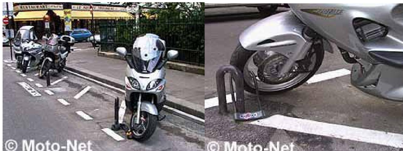
Figure 6 : aménagements de stationnement 2-roues motorisés sur voirie à Paris (angle de 60 degrés par rapport à la chaussée, arceaux antivols hauts de 50 cm, marquage au sol entre chaque emplacement)
