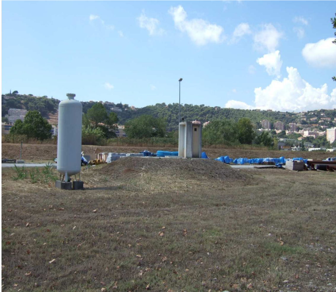
Vue générale du forage F2 (Cliché NCA)
