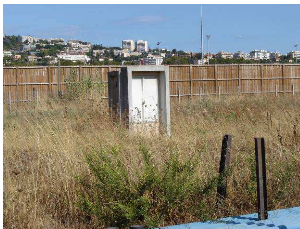
Figure 14 : Photo de la tête d'ouvrage du puits F2 (Hydratec, septembre 2008)
