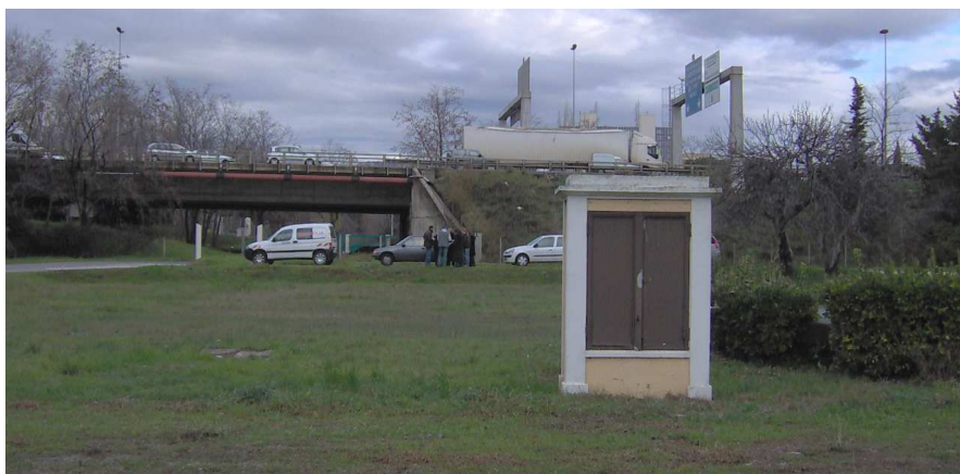
Figure 12 : Photos des têtes d'ouvrages des puits P11 et P4 (Hydratec, septembre 2008)
