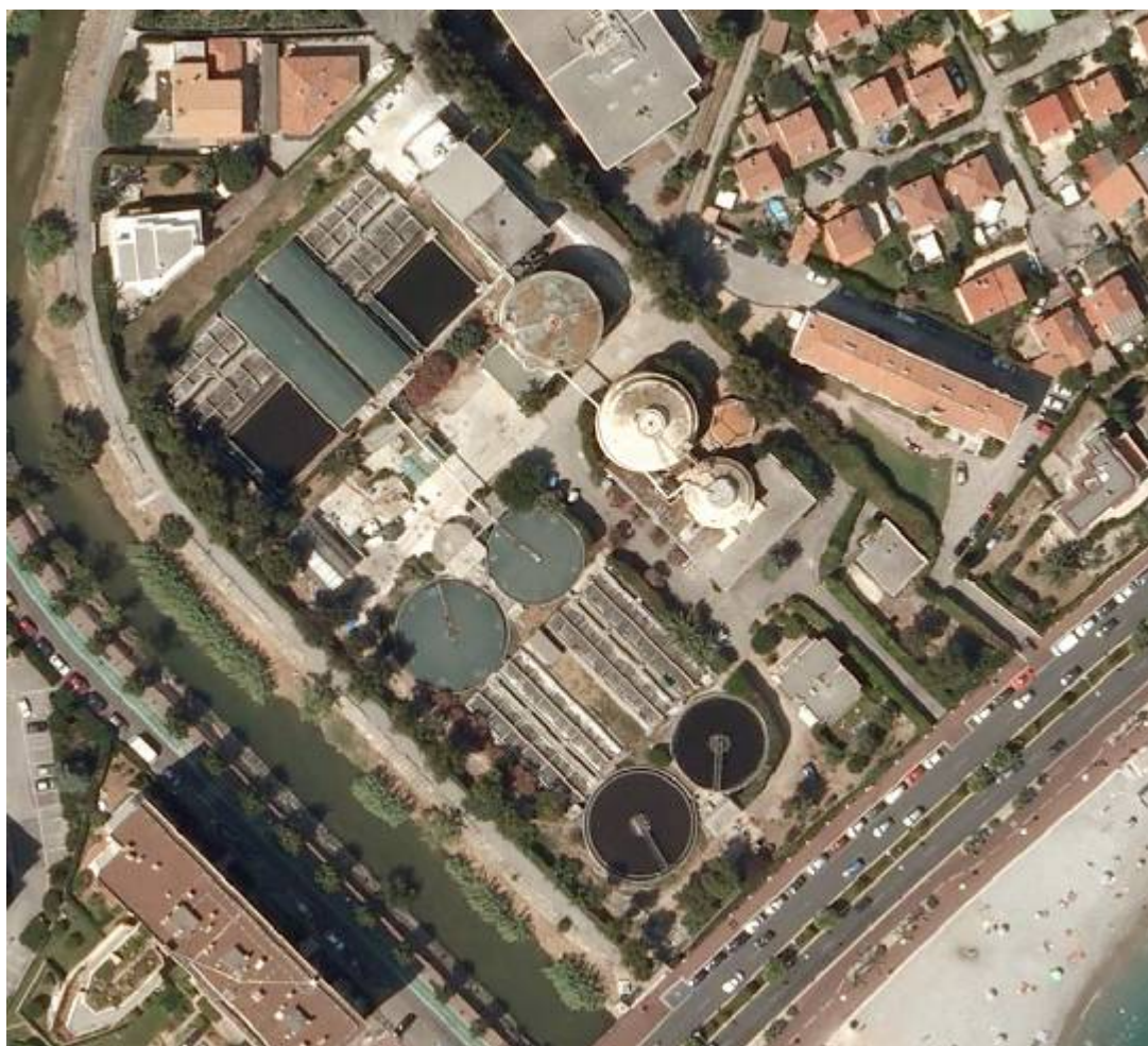
Vue aérienne de la STEP intercommunale de Cagnes-sur-mer
