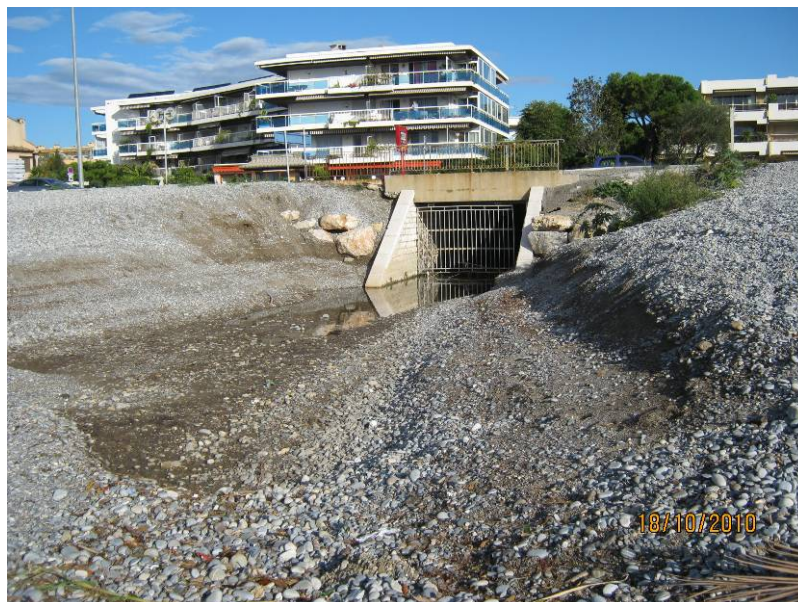
Photographie : Exutoire du vallon des Espartes en limite Est de la plage du Port
