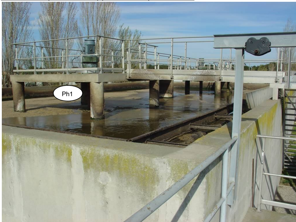
Photo 1 : Usure érosion, fissuration
