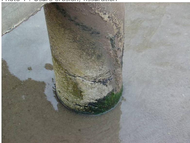
Photo 1 : Usure érosion, fissuration
