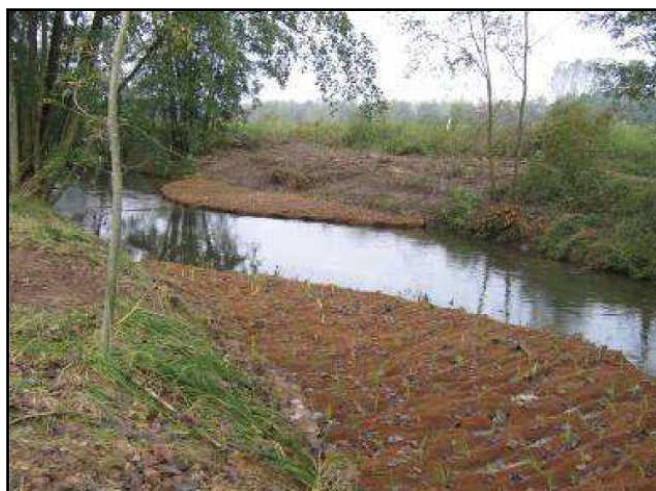
Exemple de banquette réalisée sur la Veyle (01) : chenal ici plus large et protection en pieds de type tressage
