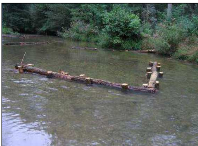
Exemple d'épis déflecteur central réalisé sur la Veyle (01)
