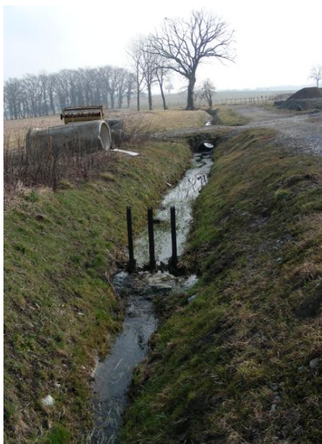
Figure 44 : Ruisseau des Dumonts (vue depuis l'aval) (Source: photo CIDEE)
