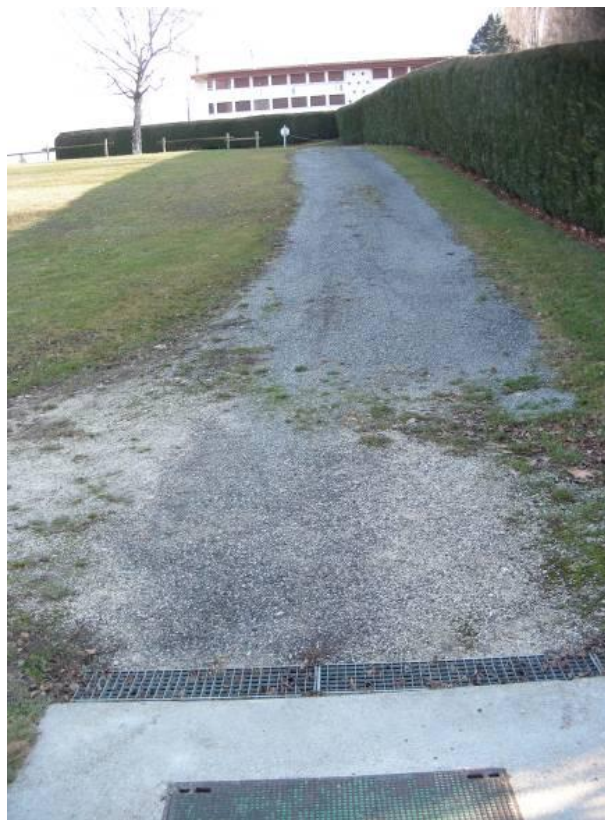
Figure 58 : Voie d'accès à la station au poste de relevage (Source: photo CIDEE)
