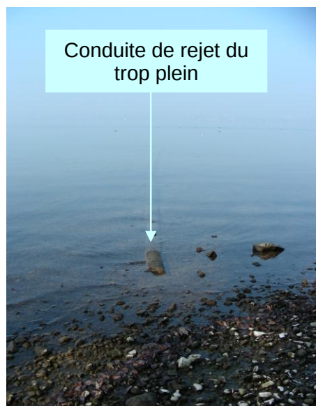
Figure 49 : Trop plein du poste de refoulement de la zone de baignade de La Pointe (Source: photo CIDEE)
