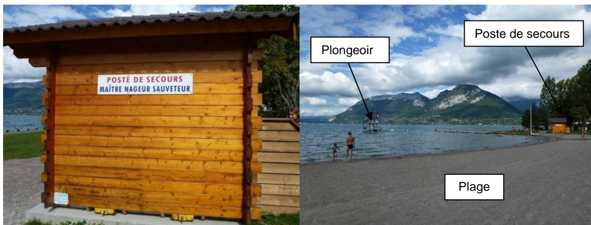
Figure 20 : Poste de secours de la Plage Municipale de Saint-Jorioz
