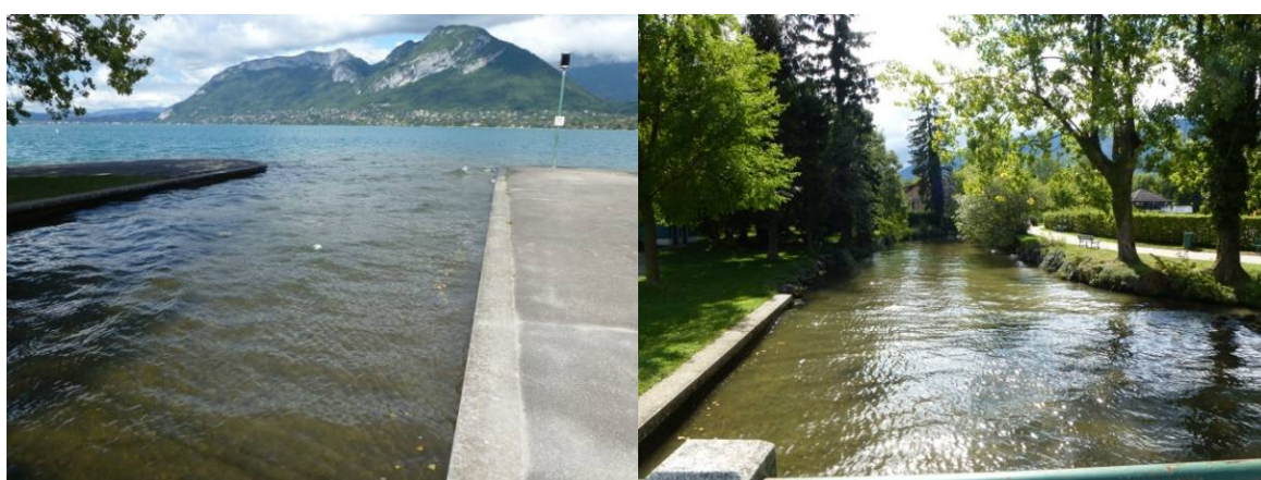
Figure 8 : Affluence du Laudon à Saint-Jorioz (Source : photos CIDEE)
