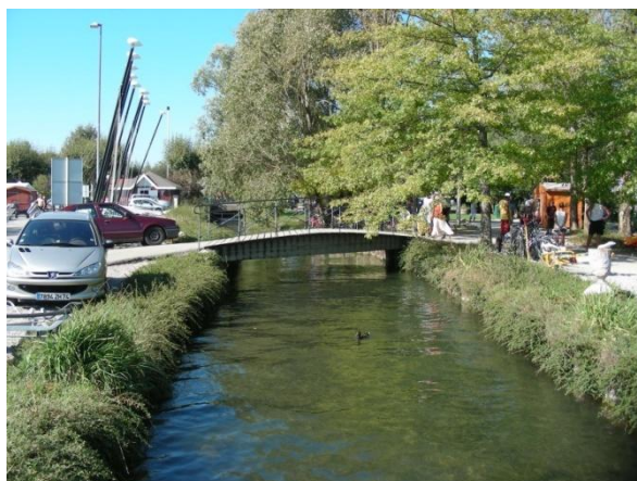
Figure 36 : Exutoire du cours d'eau du Colovry (Source: photo CIDEE)
