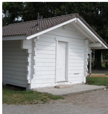
Figure 22 : Bâtiment (chalet MNS) – zone d'affichage (source : photo CIDEE)
