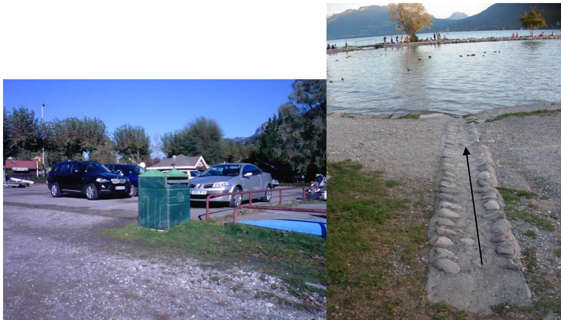
Figure 52 : Rejet d'eaux pluviales au niveau de la zone de baignade libre sur la plage d'Albigny (Source: photos CIDEE)
