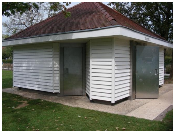
Figure 25 : Toilettes au niveau de la zone de baignade d'Albigny
