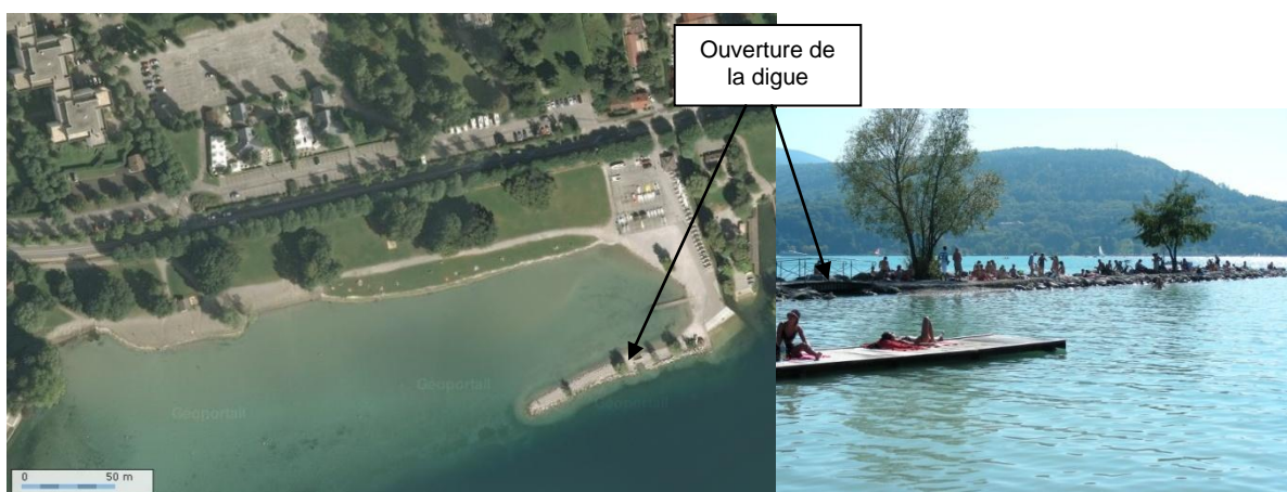
Figure 56 : Digue au niveau de la zone de baignade d'Albigny
