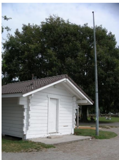
Figure 19 : Poste de secours de la zone de baignade d'Albigny (Source: photo CIDEE)
