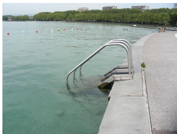
Figure 19 : Escaliers permettant l'accès à l'eau au niveau de la zone de baignade de l'Impérial (Source : photo CIDEE)
