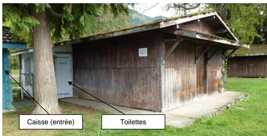
Figure 22 : localisation des sanitaires (source : photo CIDEE)
