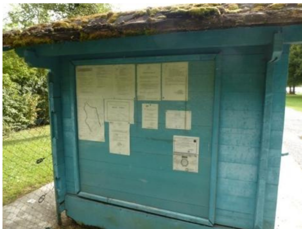
Figure 21 : zone d'affichage au niveau de la caisse à l'entrée (source : photo CIDEE)
