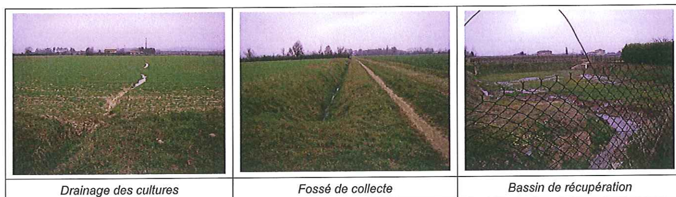
Figure 09-085/69-18 : Réseau de drainage des cultures
