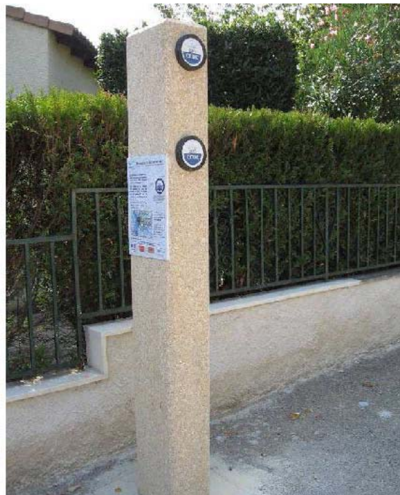
Figure 1 : exemple de repère de crue (source : SMAGE des Gardons)
