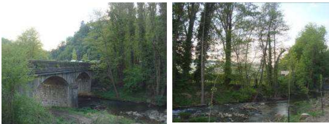
Figure 2-20 : Passage en encorbellement sur le pont et pose en rive gauche
