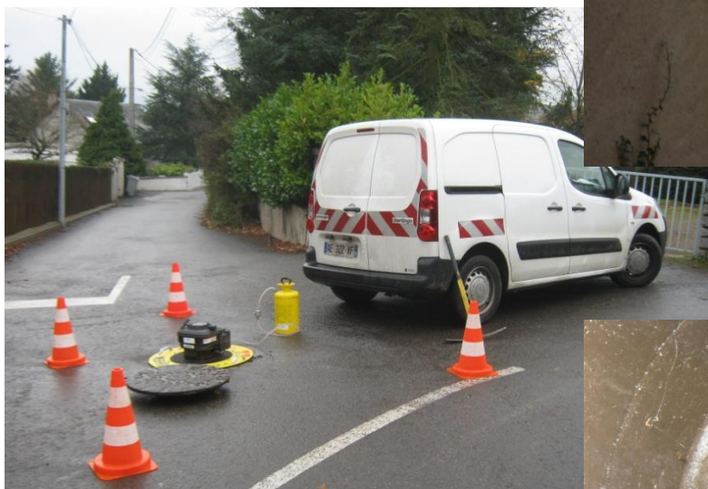
1 - Injection de fumée dans le réseau d'eaux usées
