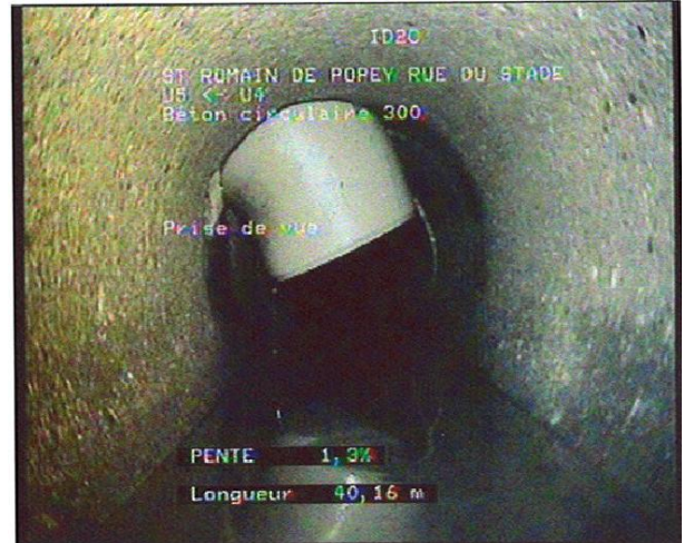
Raccordement pénétrant, Rue du Stade
