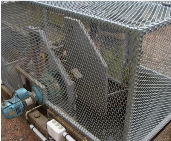
Dégrilleur automatique
