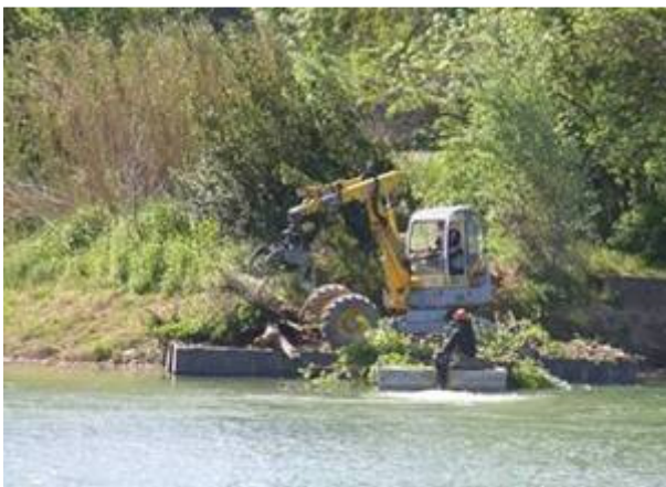
Figure 6 : méthode de réhabilitation : travail sur barge - Albières (11)
