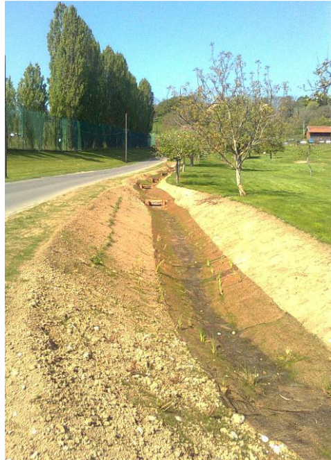
Figure 3 : noue paysagère (phase chantier avant reprise des végétaux) - Reignier-Arcine (74)
