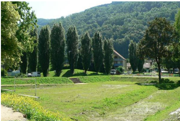
Figure 1 : bassin de rétention de 3500 m 3 en milieu urbain - Villard-Bonnot (38)
