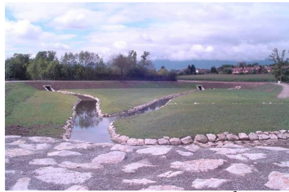
Figure 2 : bassin de rétention de 28 000 m 3 en milieu semi-urbain - Preveysin-Moens (01)
