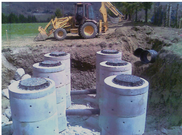
Figure 4 : puits d'infiltration (phase chantier) - Essert-Romand (74)
