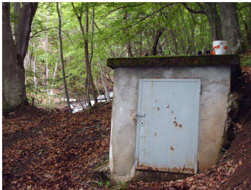
Répartiteur / vue extérieure
