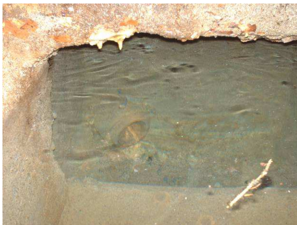
Captage de la Fontoune / drain
