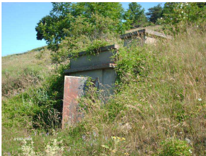
Réservoir de Sainte Luce / vue extérieure
