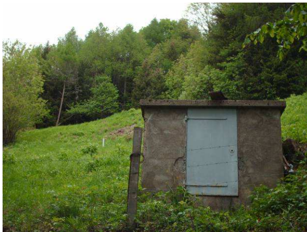
Captage des Sagnes / vue extérieure
