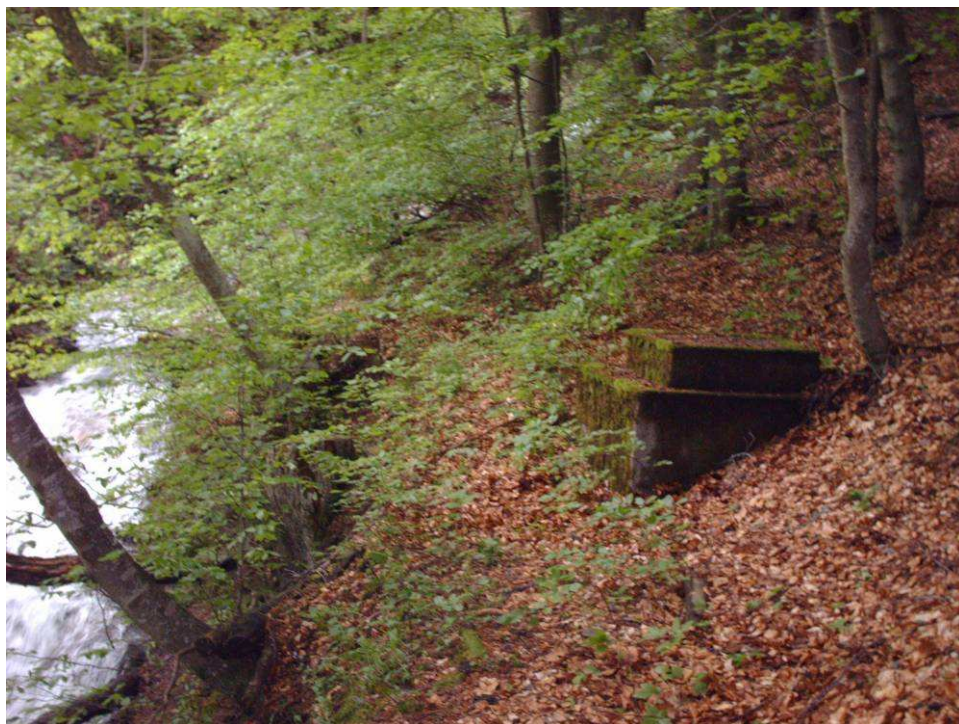
Le captage des Achards
