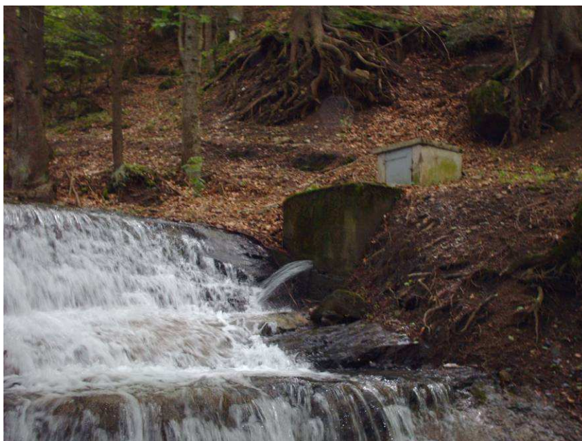
Captage de la Fontoune / vue extérieure
