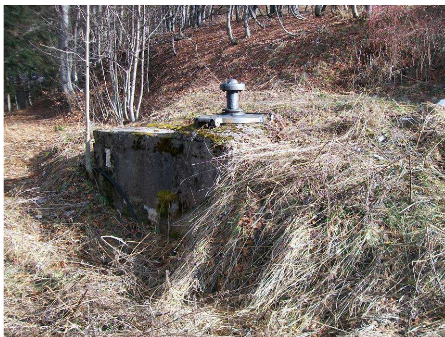
Réservoir des Achards / vue extérieure
