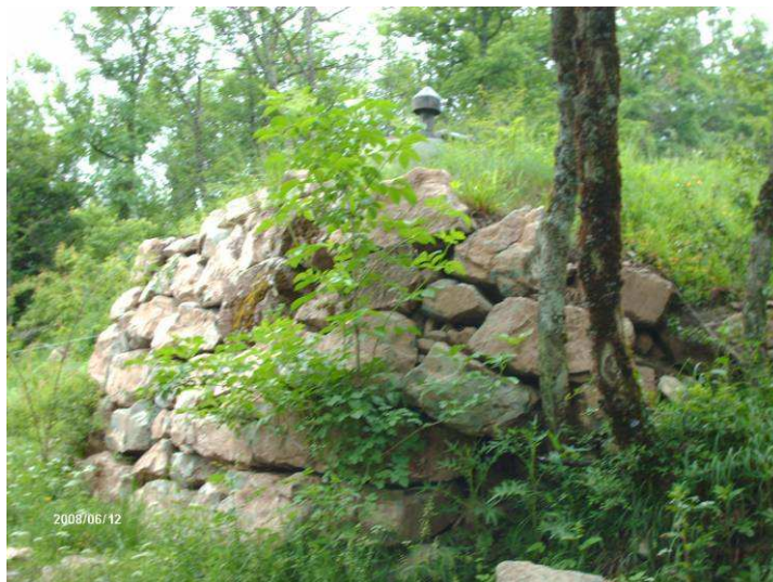
Réservoir du Cros / vue extérieure
