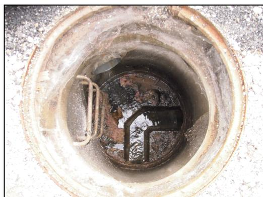
**Photo 9 : dépôts dans radier et sur banquette (regard N°138)**
