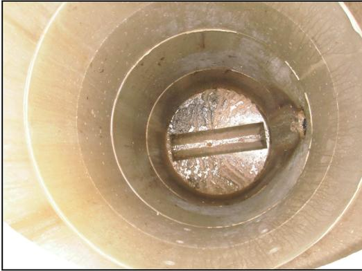
**Photo 14 : écoulement régulier d'eaux claires en provenance d'un branchement particulier (regard N°98)**
