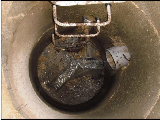
Photo 10 : obstacle à l'écoulement, rejet branchement dans échelon, dépôts (regard N°240)
