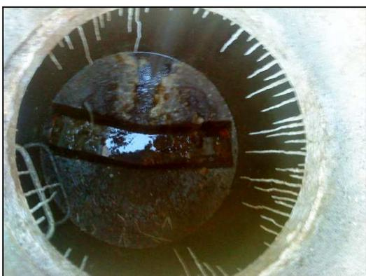
**Photo 12 : faibles infiltrations d'eaux claires à l'origine de concrétions calcaires (regard N°347)**
