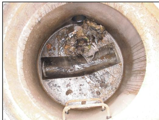
**Photo 7 : obstacle à l'écoulement, amas de dépôts (regard N°19)**
