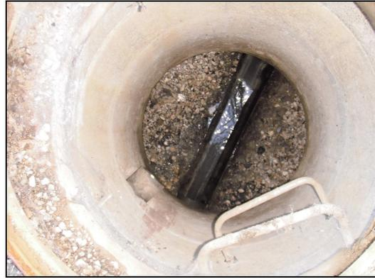
**Photo 15 : écoulement régulier d'eaux claires en provenance d'un réseau privé desservant une résidence (regard N°241)**
