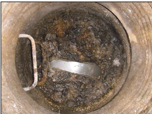
**Photo 6 : dépôts importants et traces de mise en charge (regard N°347)**
