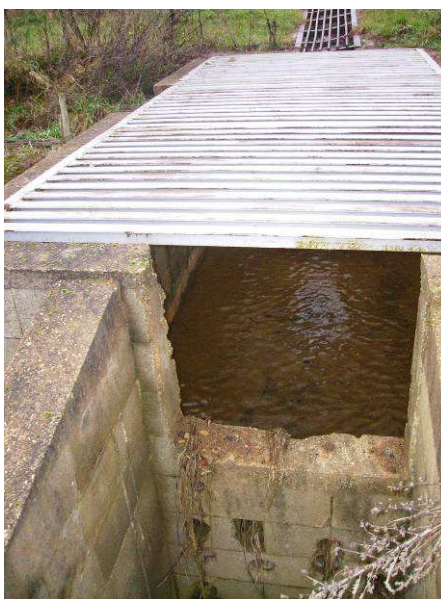
Dessableurs sur le bassin versant de l'Arlois (Chasselas)
