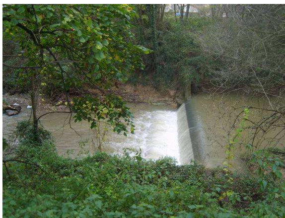
Seuil sur la Mauvaise à La Chapelle-de-Guinchay
