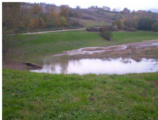
Bassin de rétention sur le Préty à St Vérant
