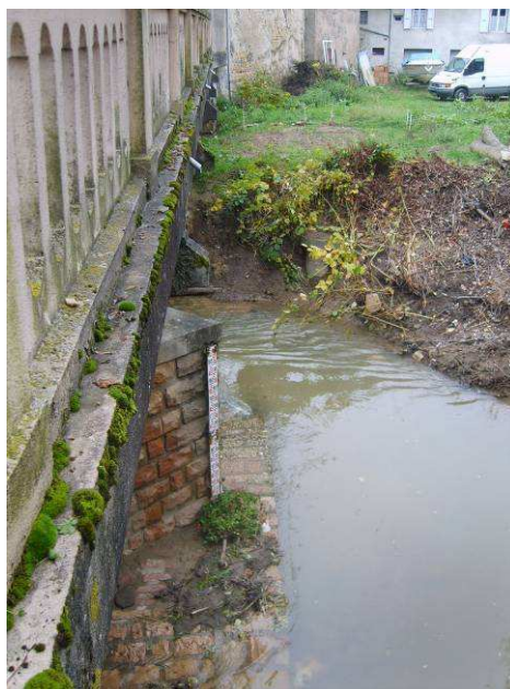
Échelle limnimétrique sur la Mauvaise en amont du pont de la RN6
