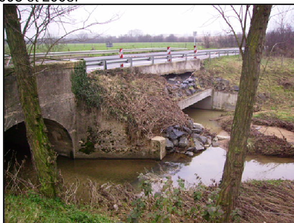
Pont de la RD 45 avec voûte principale à gauche et cadre de décharge à droite
