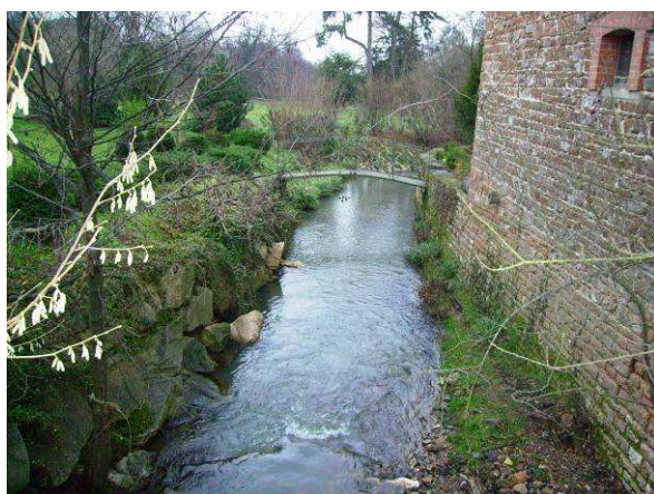
Aval du pont de l'Auberge de St Vérand
