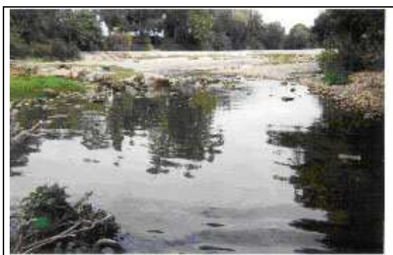
← Le Vidourle à Boisseron en aval du seuil
