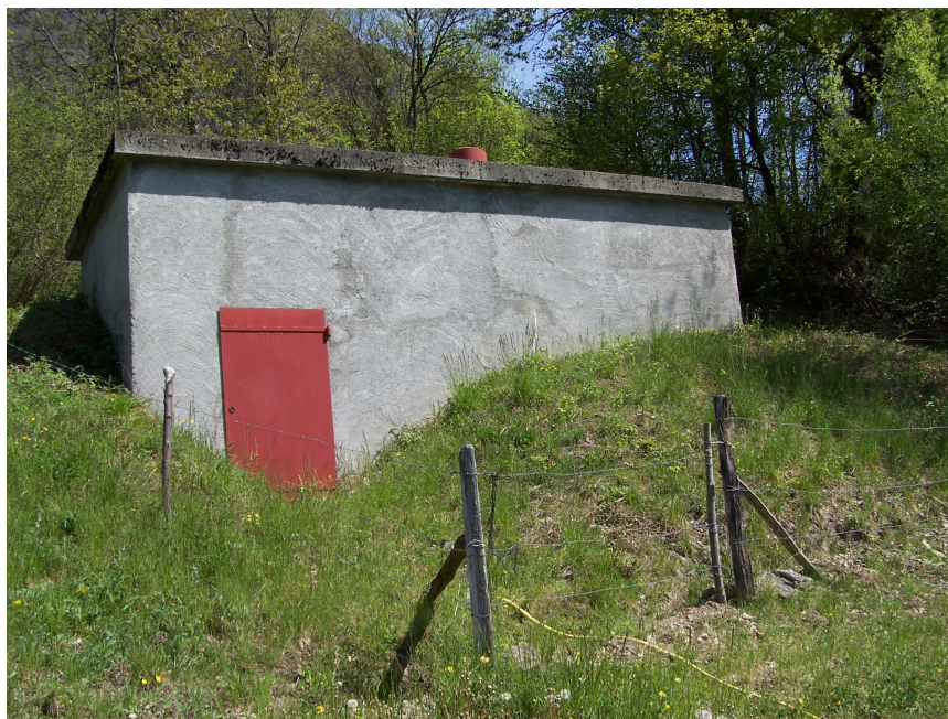
Photo n°3 : Vue générale de l'ouvrage
