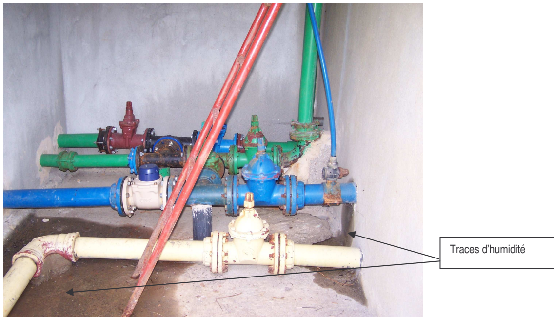
Photo n°4 : Vue partielle de la chambre des vannes (partie inférieure)
