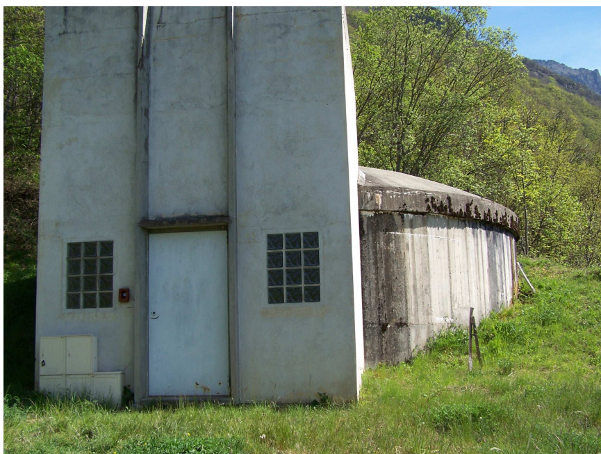
Photo n°1 : Vue générale de l'ouvrage
