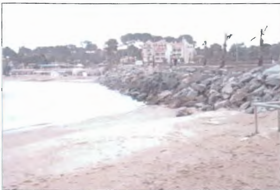
Figure 43 : Enrochements (Plage de Saint-Aygulf)
