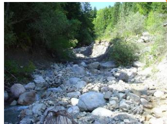
Photo 43 : Erosion des deux berges
