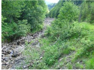
Photo 1 : Affaissement de versant en rive gauche source de matériaux
