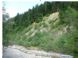
Photo 21 : zone d'affaissement de versant stabilisé par une protection de berge (déconnexion)
