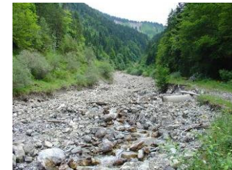
Photo 29 : Divagation du lit et sapement de berge. Traversée détruite
