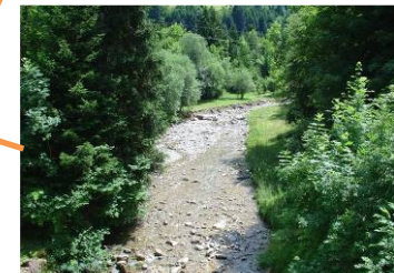
Photo 18 : Lit avec deux seuils détruits
