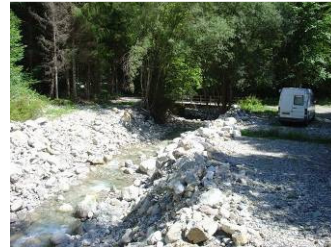
Photo 39 : Amont du pont des Meuniers
