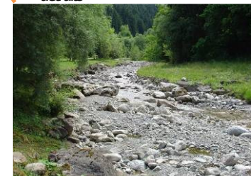
Photo 23 : Lit avec deux seuils détruits
