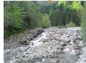
Photo 11 : Ouvrage de sortie de la plage de dépôt
