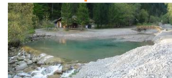
Photo 22 : Seuil et passerelle au lieu-dit les Mudry
