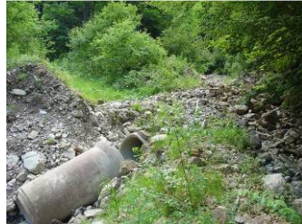
Photo 2 : Traversée détruite et obstruée par lave torrentielle
