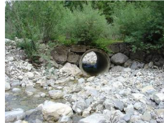
Photo 3 : Traversée \varnothing 2000
