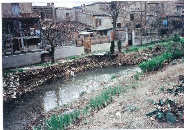
Erosion à Castelreng
