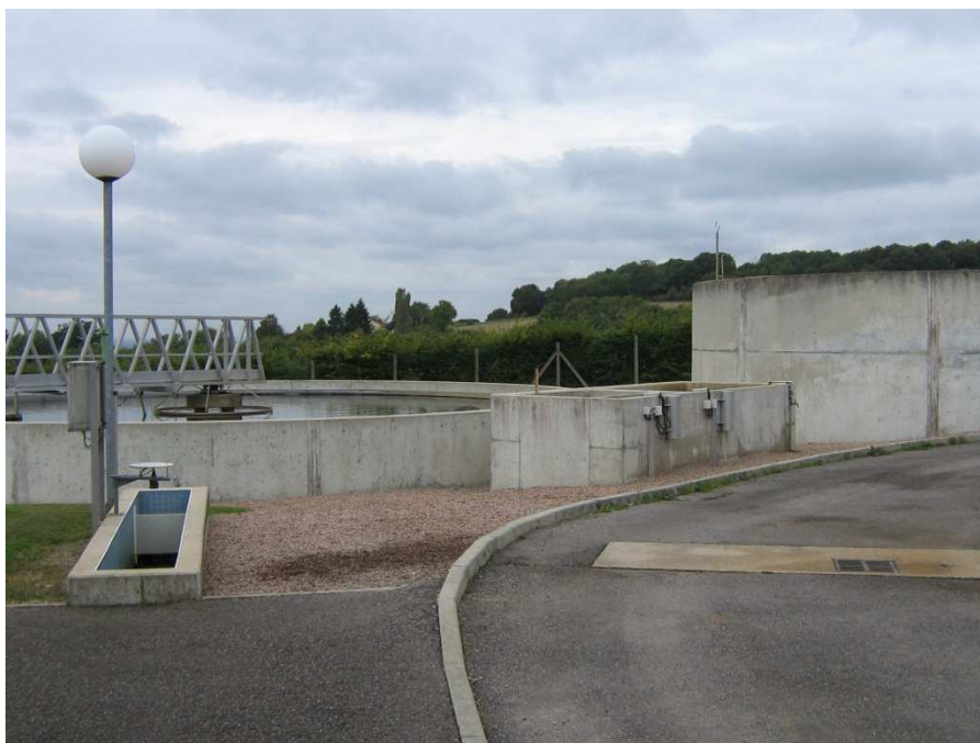
Boues activées à aération prolongée (source G2C)
