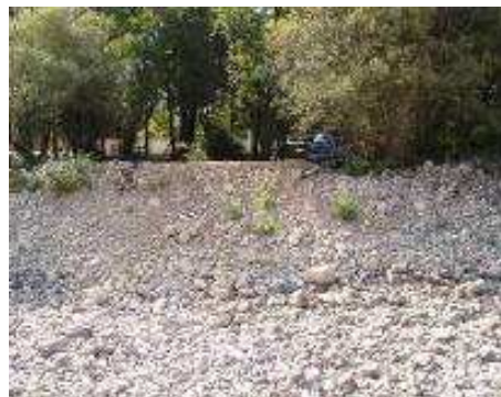
Figure 2-32 – remblai à protection du camping Les Plots - Ibie
