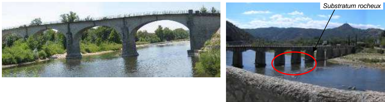
Figure 2-22 – pont RD 114 sur l'Ardèche à Lanas (à gauche) et pont RD 161 sur l'Ardèche à Sampzon (à droite)
