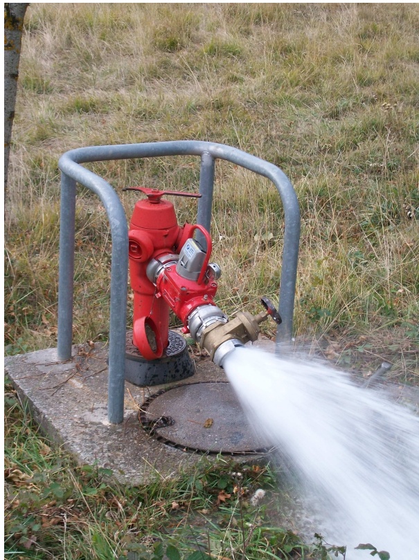
Mesure d'un poteau incendie
