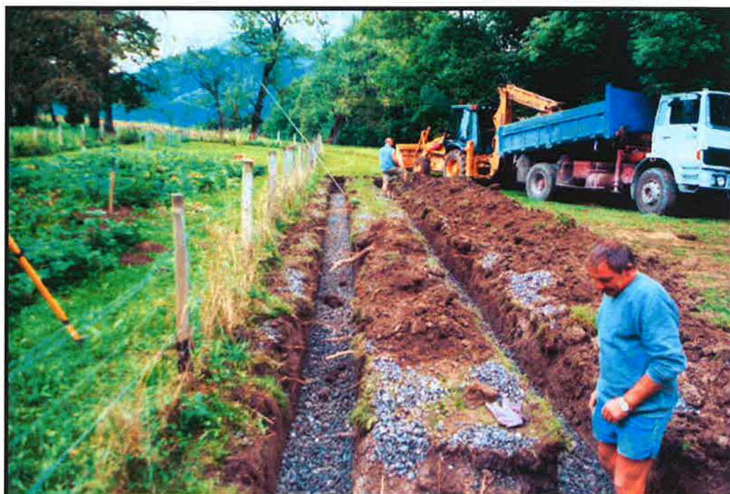
Tranchées d'épandage en cours de réalisation
