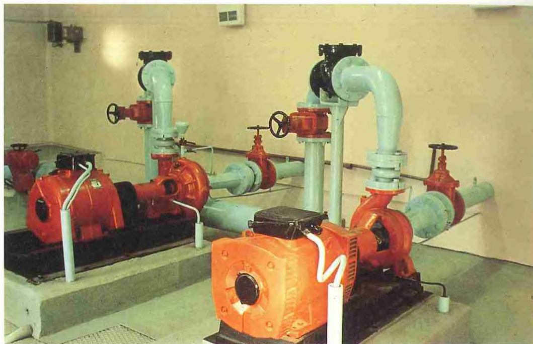
Usages des plans d'eau. Pompage dans le lac du Bourget en vue de l'alimentation en eau potable de la commune de Tresserve. (Photo CGE).
