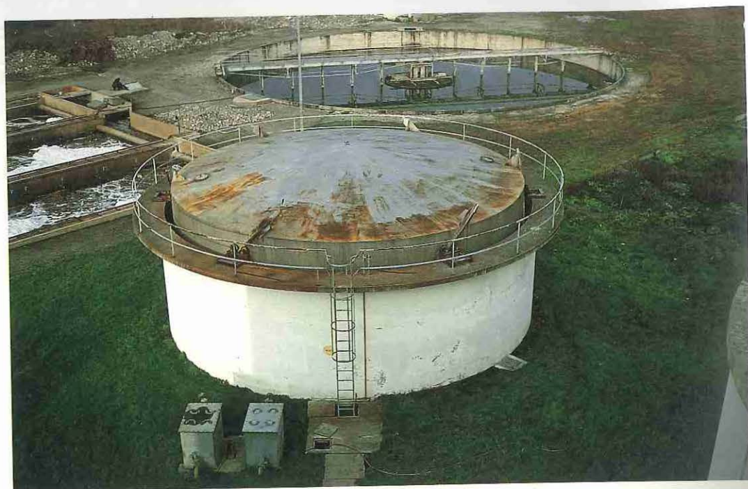
Dégradation - Protection - Restauration. Station d'épuration de Thonon-les-Bains protégeant le lac Léman de la pollution. Premier plan, cloche à gaz; second plan, décanteur; à gauche, bassin d'aération pour le traitement biologique des boues (Photo Agence de Bassin RMC).
