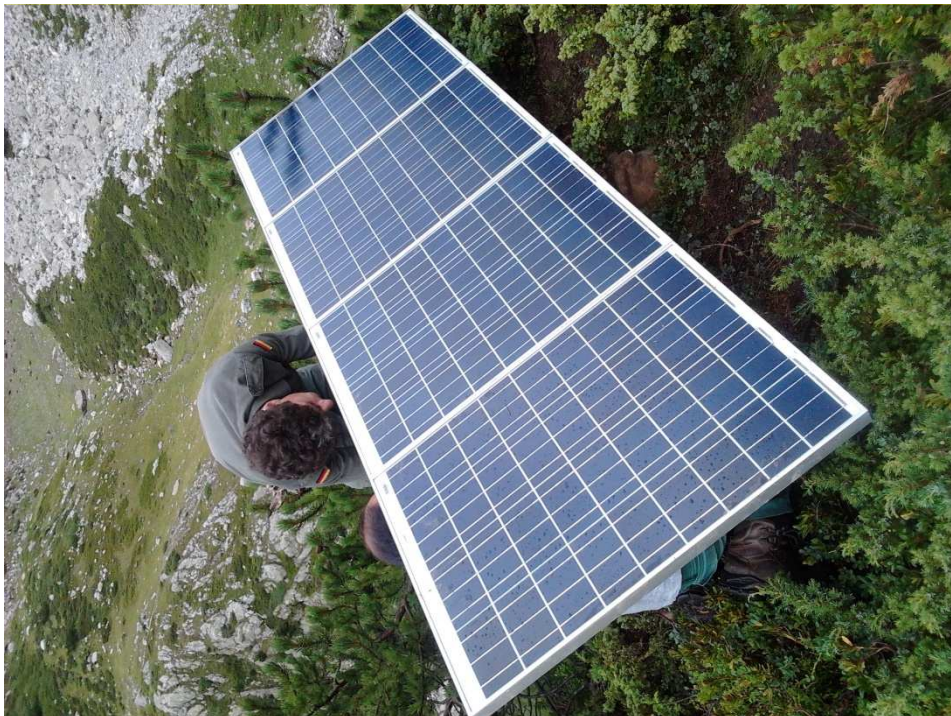
Montage des panneaux photovoltaïques à la station botanique Danilo Re
