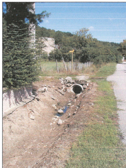
photo n°1 :fossé allée des Muguets
