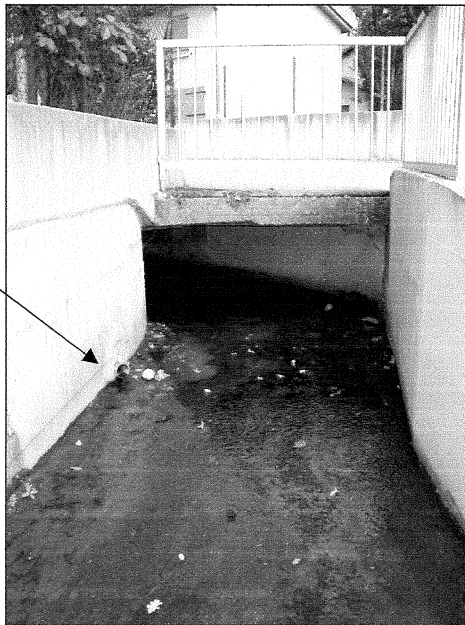
photo n°2 : ruisseau du Bresselon canalisé le long des habitations.
