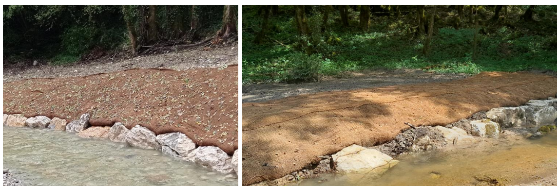
Figure 19 : Exemple de confortement entre nouveau et ancien lit avant végétalisation
