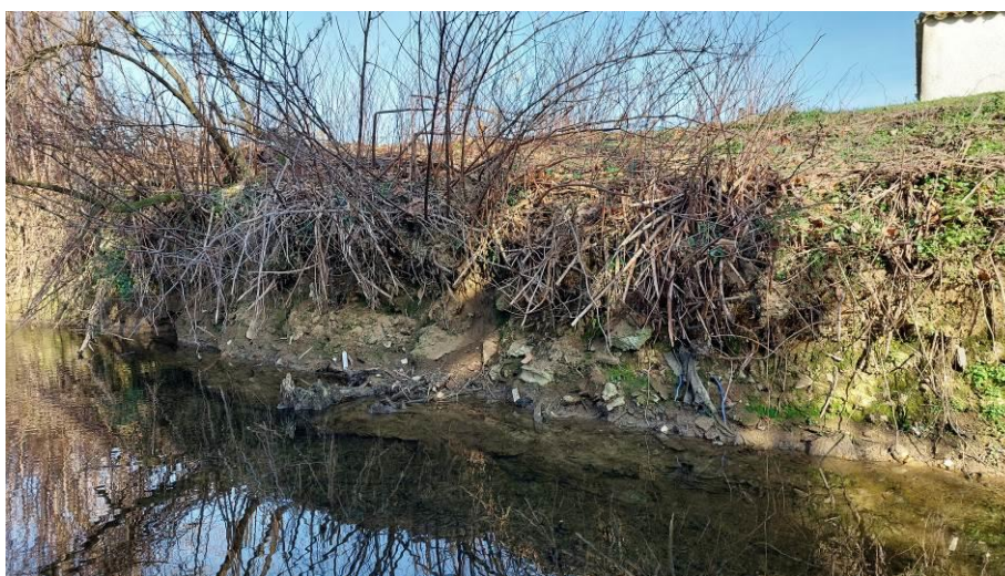
Figure 13 : berge en remblais en amont du pont communal
