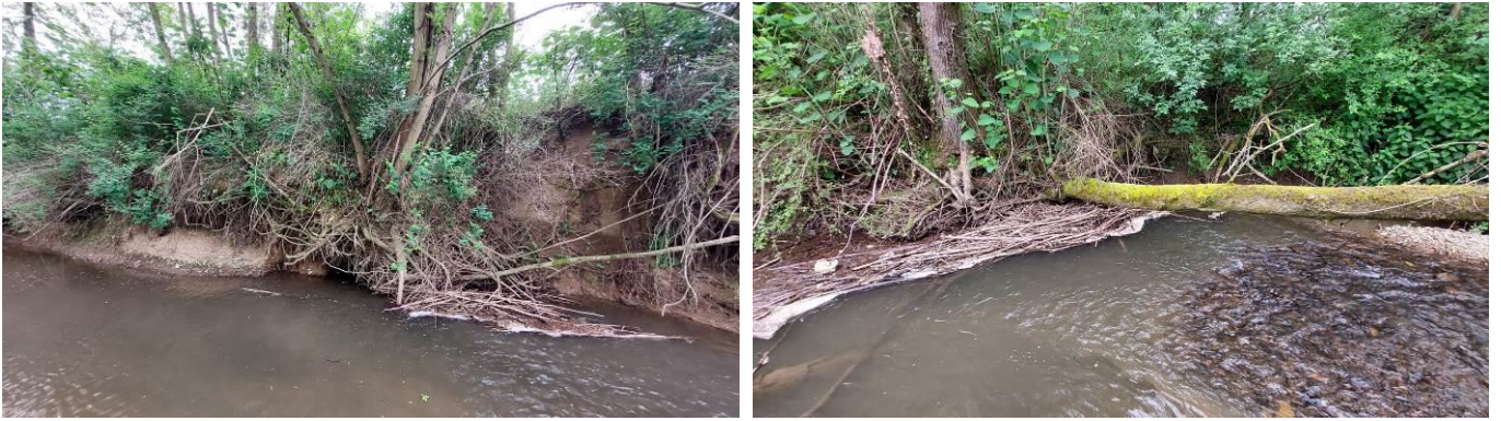
Figure 27 : Abris sous berges fonctionnels mais trop peu présents
