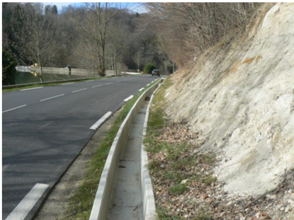
Figure 10 – Exemple de collecteur en U à l'étang de Bonne famille avec talus pentu (source : © Conseil départemental de l'Isère).
