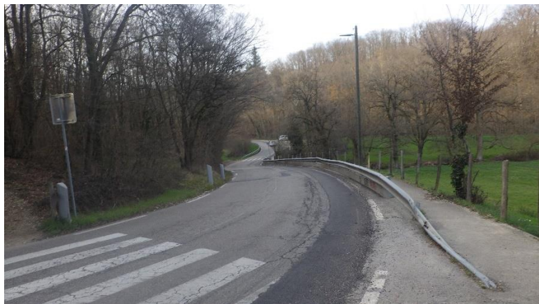
Passages piétons aux abords et dans le fond du vallon
