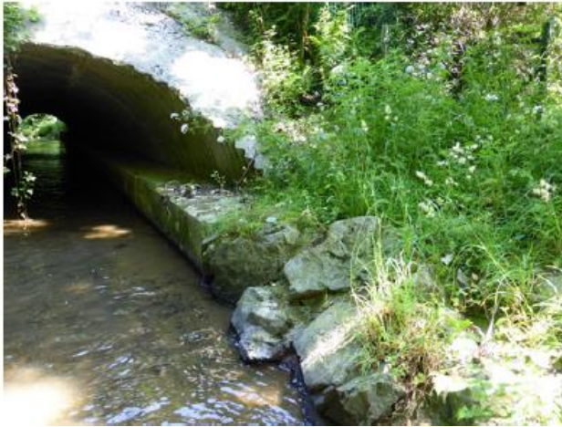
Figure 73 - Dalot de 1,20 m de large avec 2 banquettes de 0,40 m (tirant d'air : 0,80 m)
