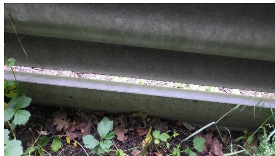
Vue depuis le pont du ruisseau du Méginand et zoom sur les glissières doublées pour des raisons de sécurité routière
