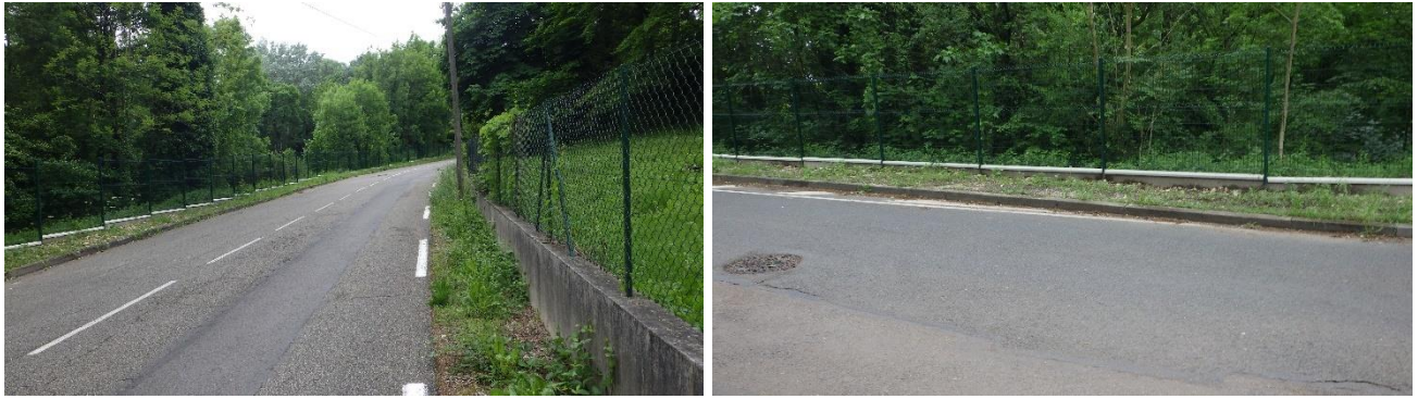
Vue sur les grillages qui bordent la voirie à l'est et qui peuvent ponctuellement à l'ouest
