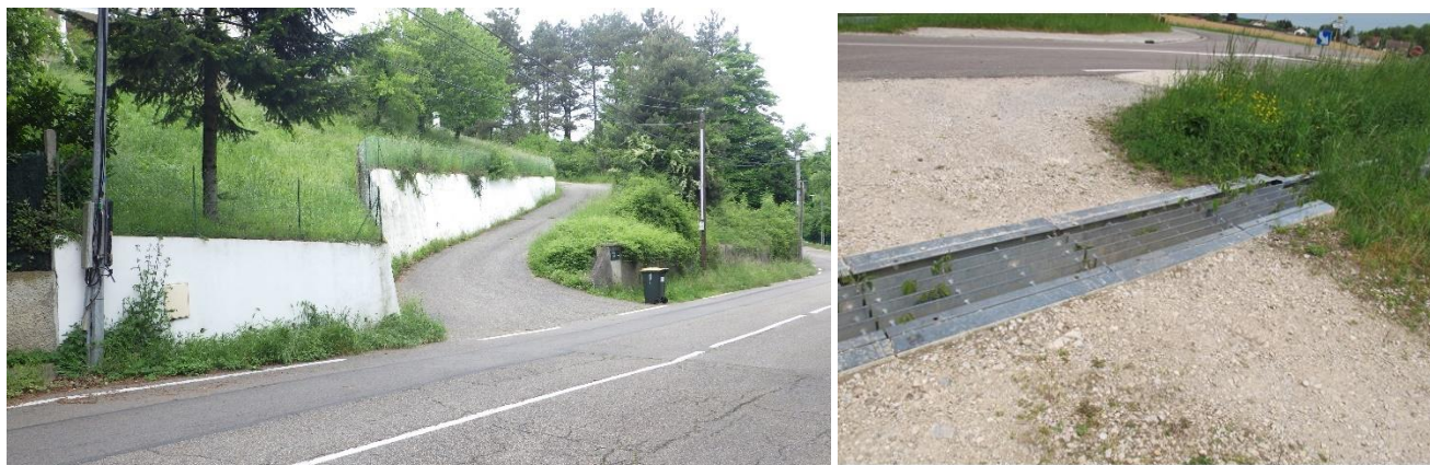
Exemple d'emplacement où un passage canadien serait nécessaire et exemple de passage canadien (CEREMA-EST, A.Morand)
