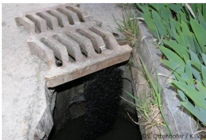
Exemples de rampes anti-noyade pour les amphibiens (LPO France) et de rampe en géotextile (info-fauna).
