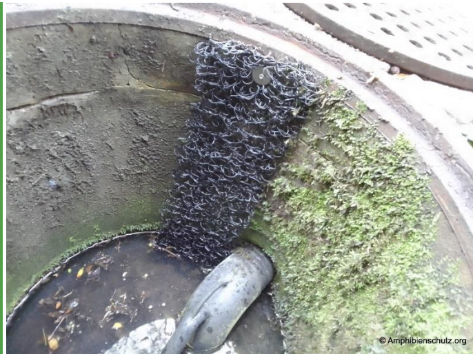
Exemple de dispositif permettant la sortie des amphibiens (amphibtec.ch) ou échelle à batraciens en géotextile
