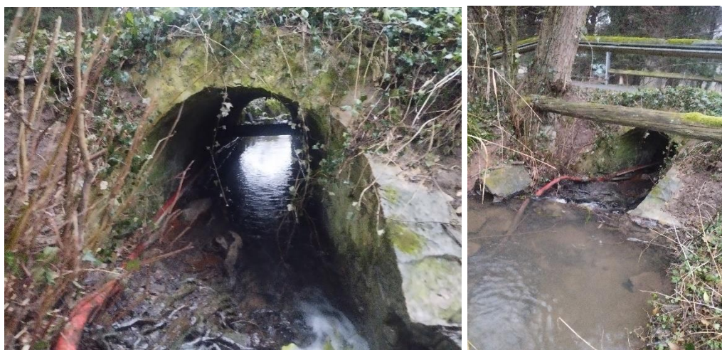
Passage du ruisseau sous la route à réaménager (pont cadre avec banquette)
