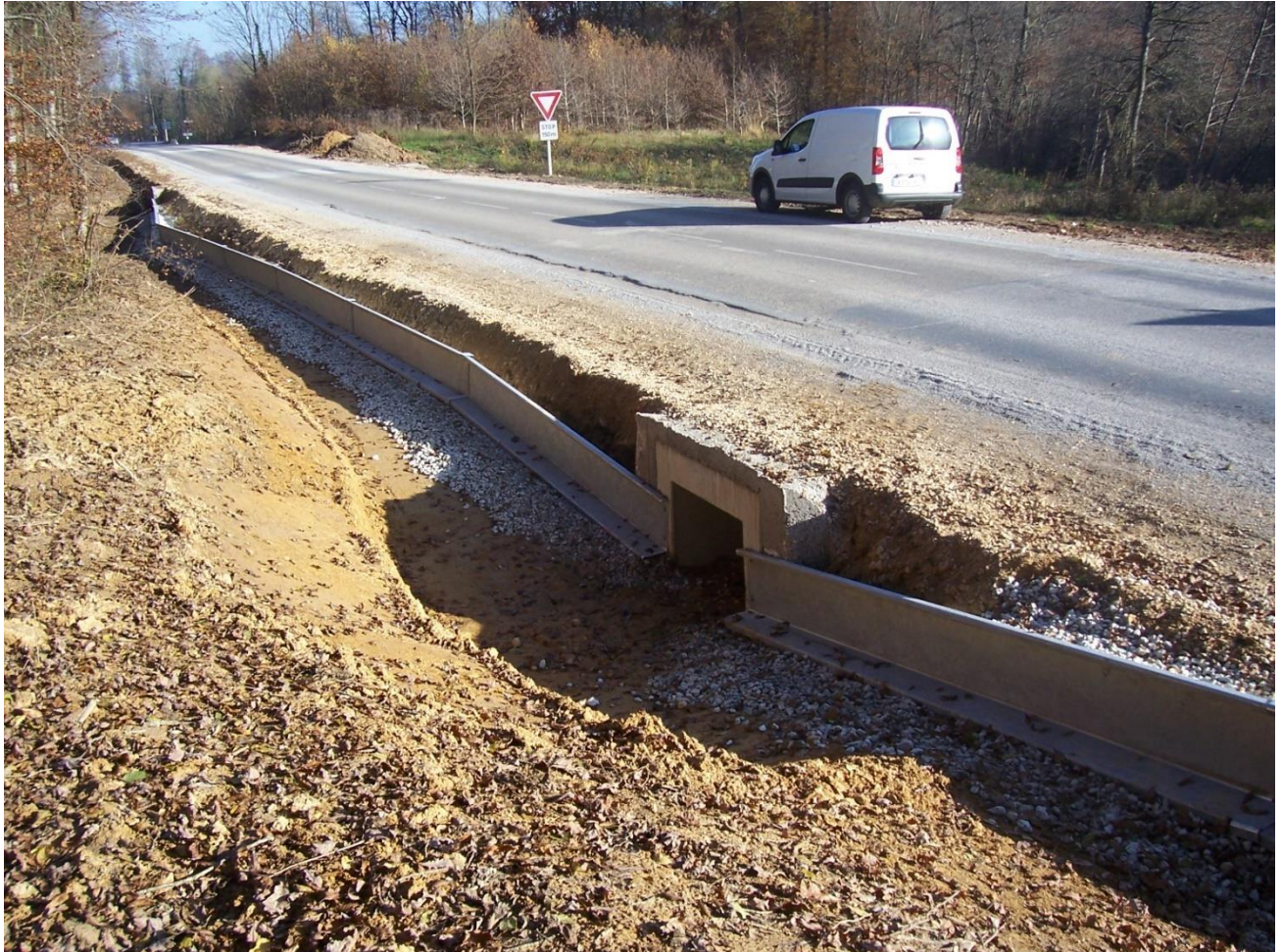
Exemple de traversée sous chaussée avec collecteurs en L juste après travaux (Geneuille, département du Doubs)
