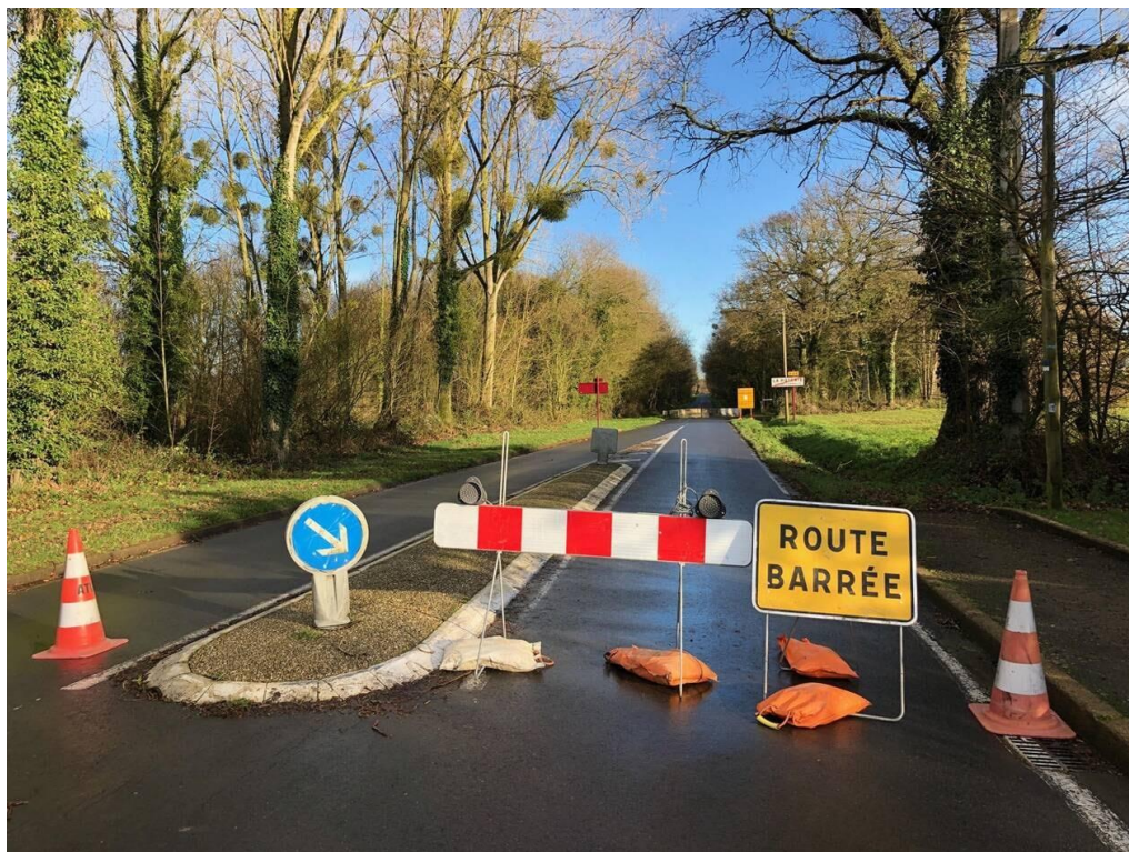
Fermeture avec installation temporaire d'un dispositif avec barrière K2 pour les amphibiens (source : archive ouest France)
