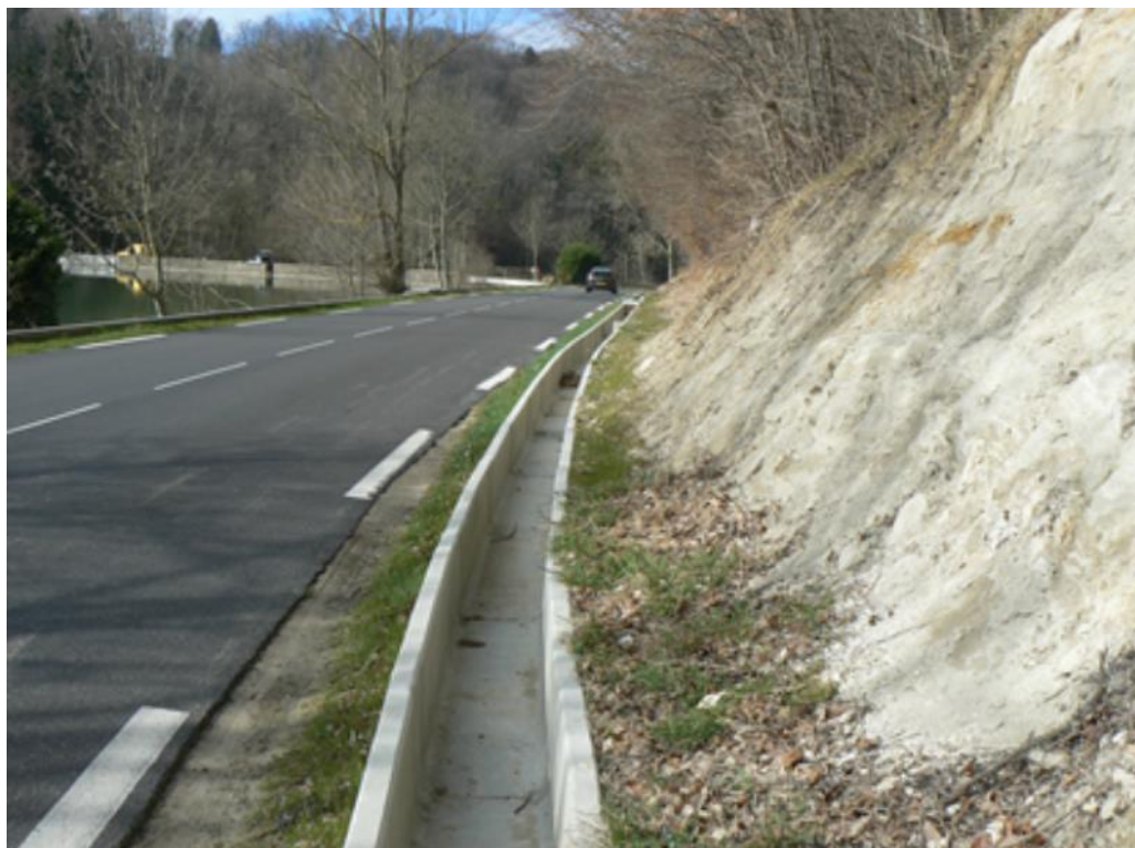
Figure 13 – Exemple de collecteur en U à l'étang de Bonne famille avec talus pentu (source : © Conseil départemental de l'Isère).
