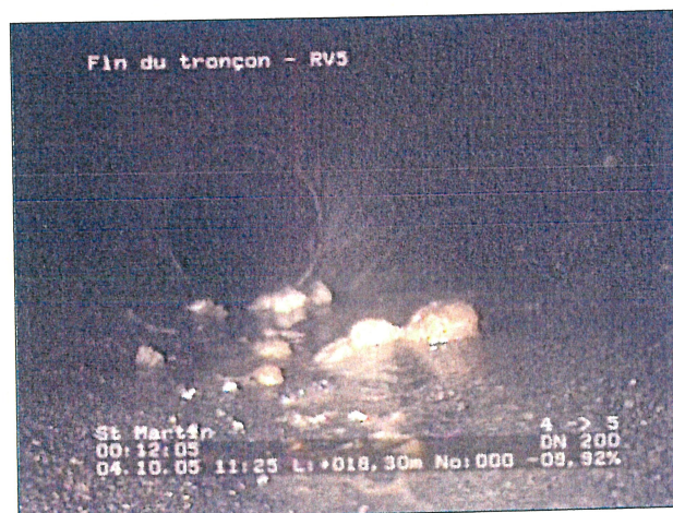
Photo: 3_5a, N° cassette: 1, 00:12:12 18,3m, Fin du tronçon - RV5
