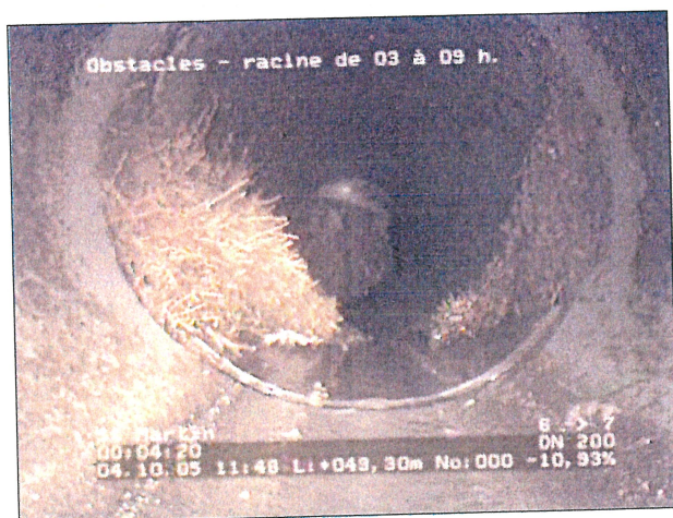
Photo: 4_4a, N° cassette: 1, 00:04:18 49,3m, Obstacles - racine de 03 à 09 h.
