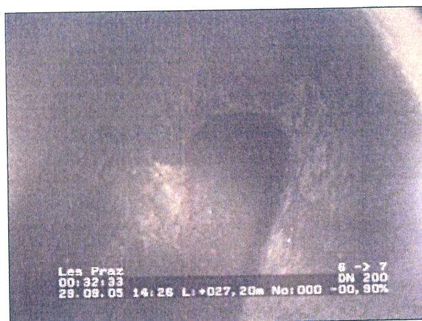
Photo: 5_7a, N° cassette: 1, 00:32:47 27,2m, Fin du tronçon - RV7 (enterré)
