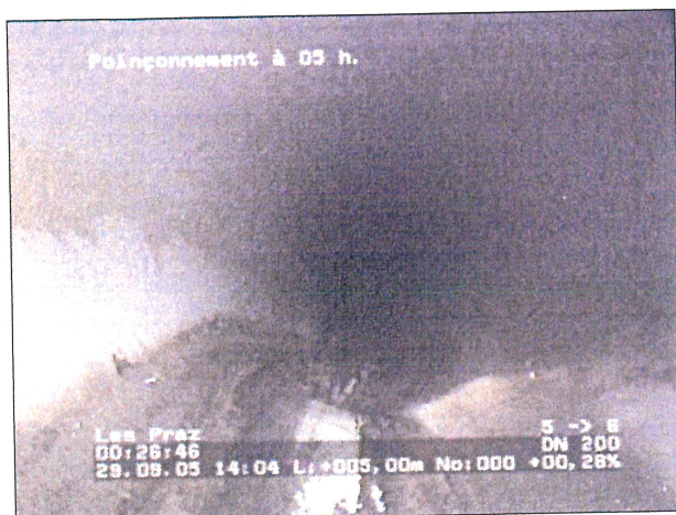
Photo: 4_4a, N° cassette: 1, 00:26:44 5m, Poinçonnement à 05 h.
