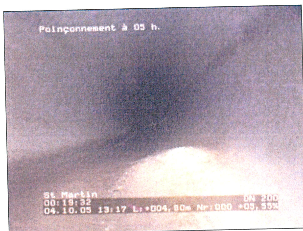
Photo: 5_2a, N° cassette: 1, 00:19:29 4,8m, Poinçonnement à 05 h.
