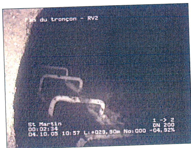
Photo: 1_4a, N° cassette: 1, 00:02:39 29,9m, Fin du tronçon - RV2
