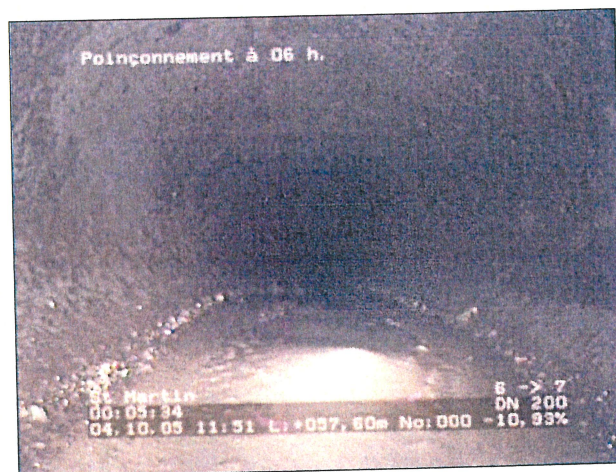
Photo: 4_7a, N° cassette: 1, 00:05:32 57,6m, Poinçonnement à 06 h.
