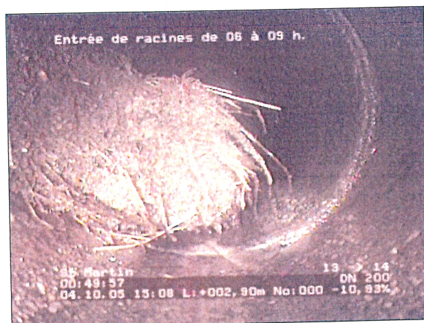
Photo: 10_3a, N° cassette: 1, 00:49:54 2,9m, Entrée de racines de 06 à 09 h.
