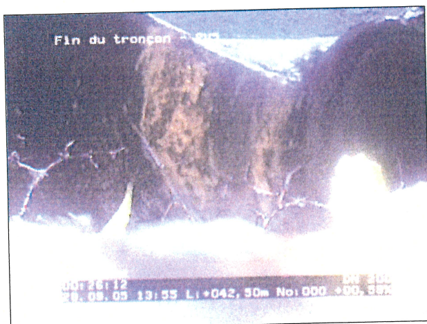
Photo: 3_10a, N° cassette: 1, 00:26:13 42,5m, Fin du tronçon - RV5
