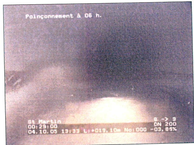
Photo: 6_3a, N° cassette: 1, 00:28:57 19,1m, Poinçonnement à 06 h.
