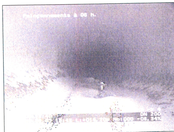
Photo: 3_5a, N° cassette: 1, 00:19:37 14,7m, Poinçonnements à 06 h.
