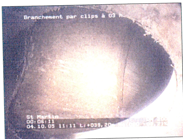
Photo: 2_6a, N° cassette: 1, 00:06:09 39,2m, Branchement par clips à 03 h.
