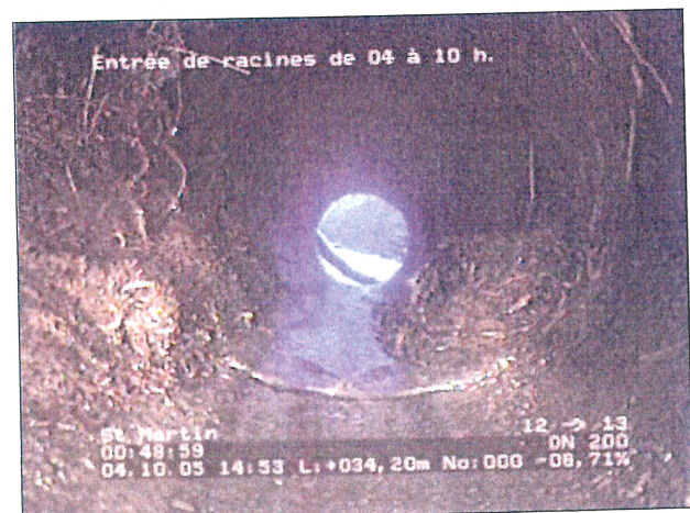
Photo: 9_9a, N° cassette: 1, 00:48:56 34,2m, Entrée de racines de 04 à 10 h.
