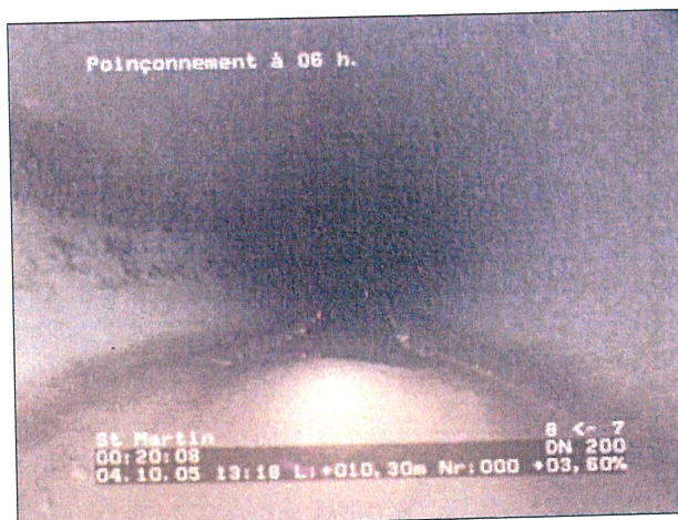
Photo: 5_3a, N° cassette: 1, 00:20:05 10,3m, Poinçonnement à 06 h.
