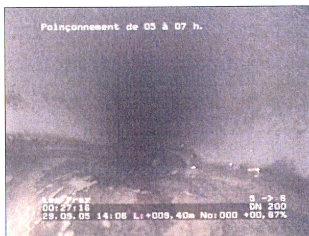
Photo: 4_7a, N° cassette: 1, 00:27:15 9,4m, Poinçonnement de 05 à 07 h.
