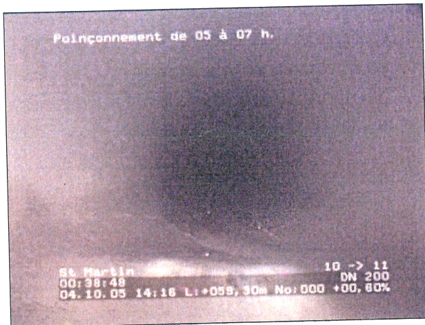
Photo: 7_10a, N° cassette: 1, 00:38:46 59,3m, Poinçonnement de 05 à 07 h.
