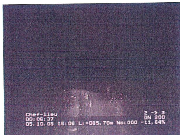
Photo: 1_8a, N° cassette: 1, 00:06:34 85,7m, Poinçonnement de 06 à 07 h.
