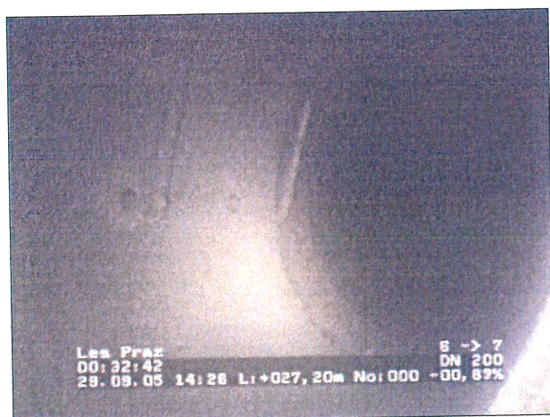
Photo: 5_7b, N° cassette: 1, 00:32:47 27,2m, Fin du tronçon - RV7 (enterré)
