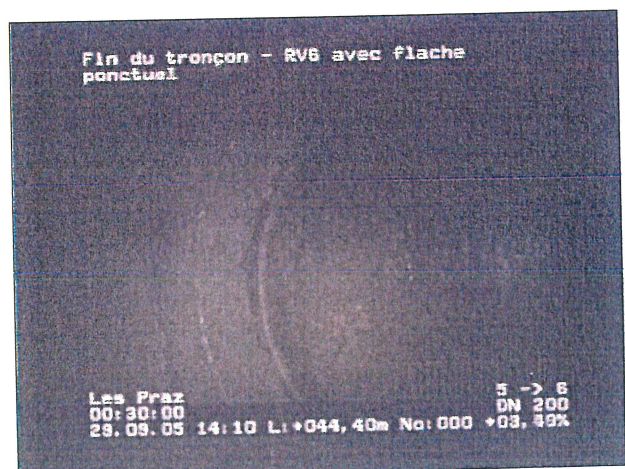
Photo: 4_12b, N° cassette: 1, 00:30:05 44,4m, Fin du tronçon - RV6 avec flache ponctuel
