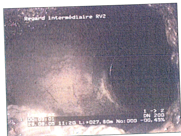
Photo: 1_5a, N° cassette: 1, 00:02:59 27,6m, Regard intermédiaire RV2 (avec traces d'infiltration - enterré)
