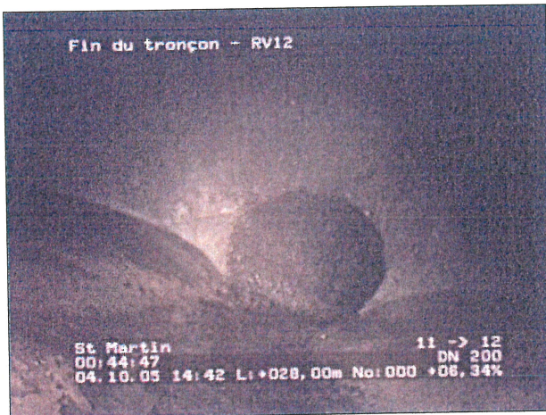
Photo: 8_6a, N° cassette: 1, 00:44:53 28m, Fin du tronçon - RV12
