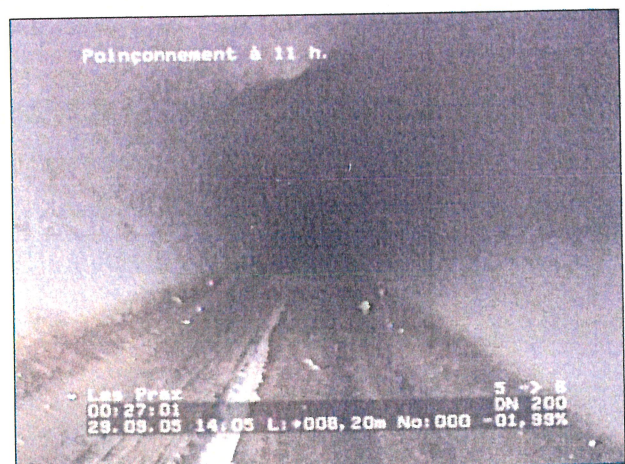
Photo: 4_5a, N° cassette: 1, 00:27:00 8,2m, Poinçonnement à 11 h.
