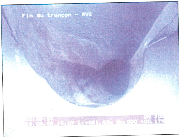
Photo: 1_2a, N° cassette: 1, 00:04:04 61,4m, Fin du tronçon - RV2
