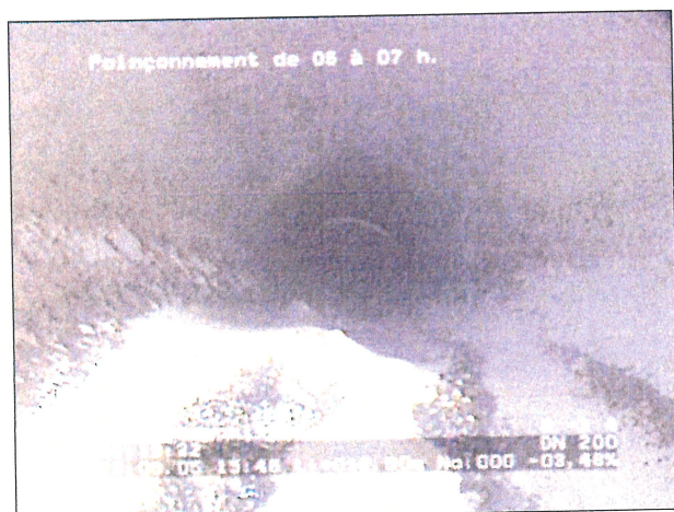
Photo: 3_4a, N° cassette: 1, 00:19:20 12,5m, Poinçonnement de 06 à 07 h.
