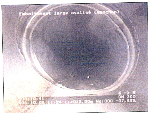
Photo: 3_4a, N° cassette: 1, 00:10:38 12m, Emboîtement large ovalisé (manchon)
