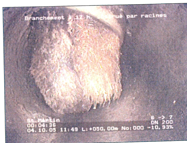
Photo: 4_5a, N° cassette: 1, 00:04:34 50m, Branchement à 12 h. obstrué par racines
