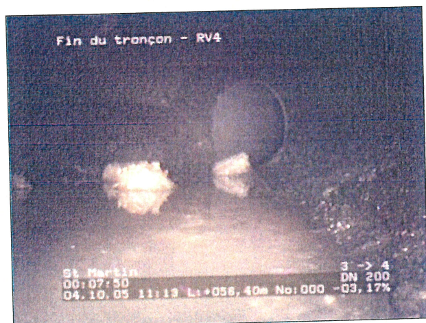
Photo: 2_8a, N° cassette: 1, 00:08:01 56,4m, Fin du tronçon - RV4
