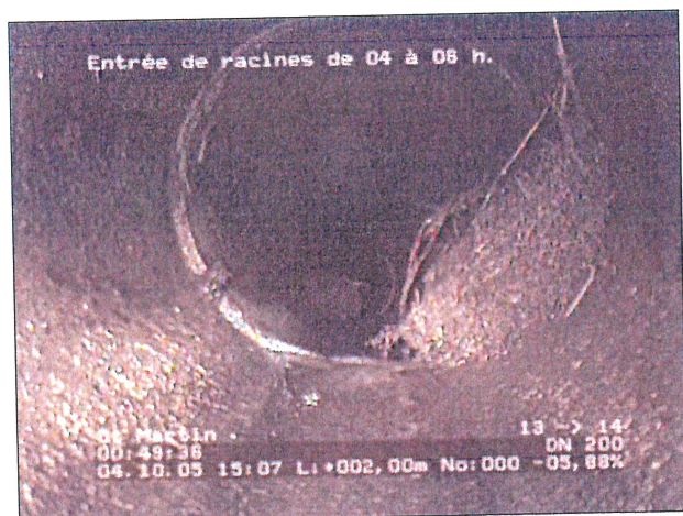
Photo: 10_2a, N° cassette: 1, 00:49:35 2m, Entrée de racines de 04 à 06 h.
