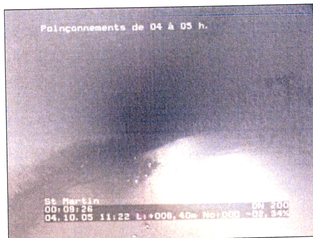
Photo: 3_3a, N° cassette: 1, 00:09:24 6,4m, Poinçonnements de 04 à 05 h.
