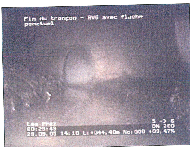
Photo: 4_12a, N° cassette: 1, 00:30:05 44,4m, Fin du tronçon - RV6 avec flache ponctuel
