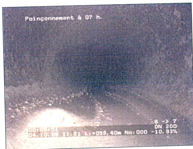
Photo: 4_8a, N° cassette: 1, 00:05:49 59,4m, Poinçonnement à 07 h.
