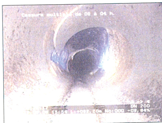
Photo: 3_9a, N° cassette: 1, 00:26:15 92,2m, Cassure multiple de 08 à 04 h.
