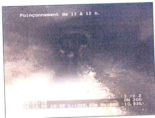
Photo: 1_2a, N° cassette: 1, 00:01:55 29,3m, Poinçonnement de 11 à 12 h.
