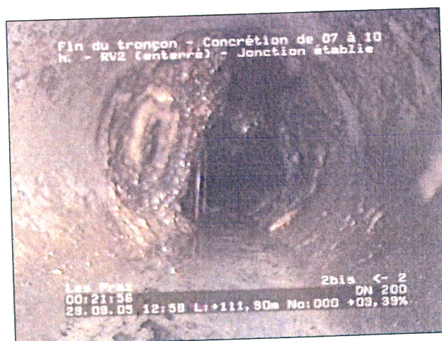
Photo: 2_13a, N° cassette: 1, 00:21:59 111,9m, Fin du tronçon - Concrétion de 07 à 10 h. - RV2 (enterré) - Jonction établie
