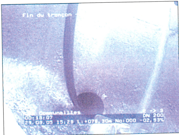
Photo: 2_2a, N° cassette: 1, 00:18:12 76,3m, Fin du tronçon - RV3
