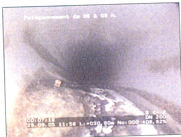
Photo: 2_6a, N° cassette: 1, 00:07:15 30,8m, Poinçonnement de 06 à 09 h.
