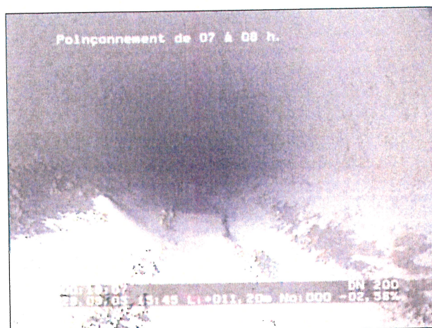
Photo: 3_3a, N° cassette: 1, 00:19:05 11,2m, Poinçonnement de 07 à 08 h.
