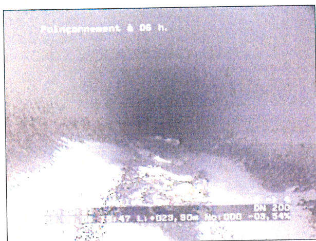
Photo: 3_6a, N° cassette: 1, 00:20:30 23,9m, Poinçonnement à 06 h.
