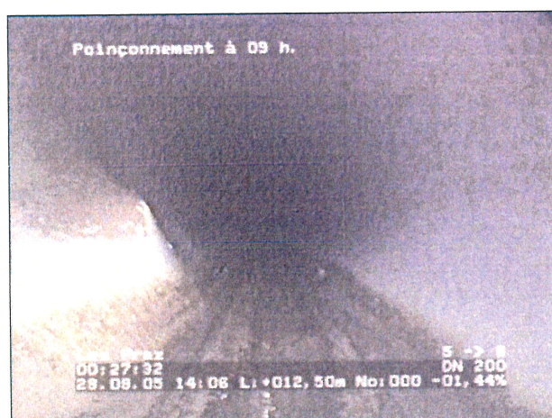
Photo: 4_8a, N° cassette: 1, 00:27:31 12,5m, Poinçonnement à 09 h.
