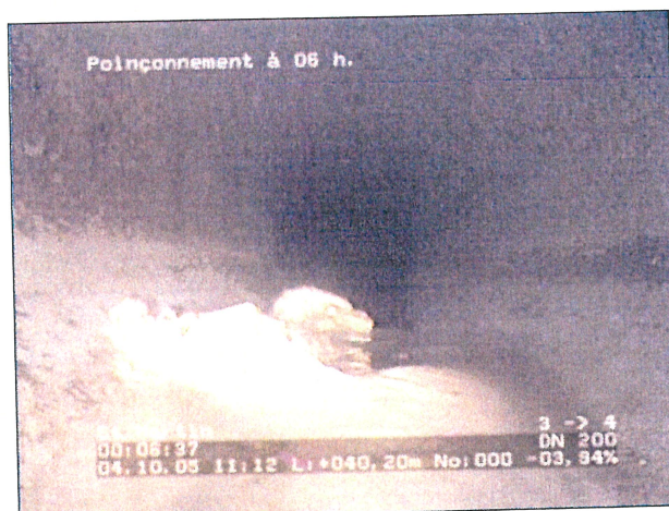
Photo: 2_7a, N° cassette: 1, 00:06:35 40,2m, Poinçonnement à 06 h.
