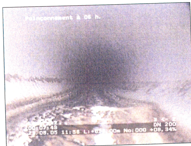
Photo: 2_7a, N° cassette: 1, 00:07:46 36m, Poinçonnement à 06 h.
