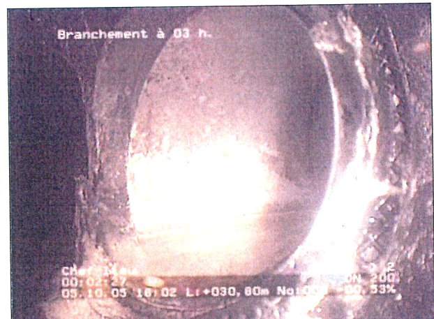
Photo: 1_3a, N° cassette: 1, 00:02:16 30,8m, Branchement à 03 h.
