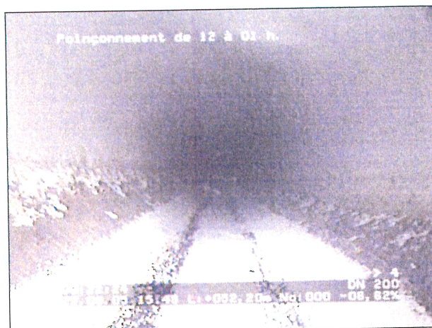
Photo: 3_7a, N° cassette: 1, 00:22:22 52,2m, Poinçonnement de 12 à 01 h.
