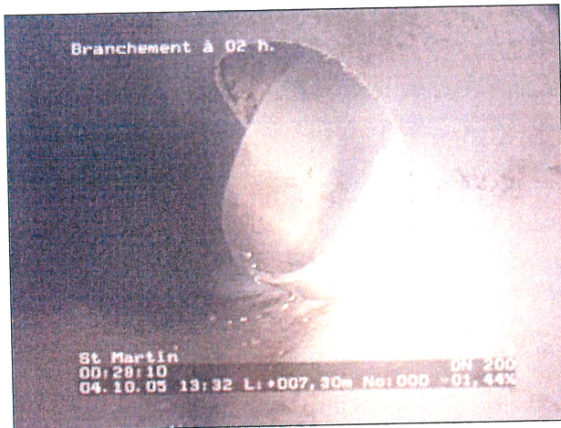
Photo: 6_2a, N° cassette: 1, 00:28:08 7,3m, Branchement à 02 h.
