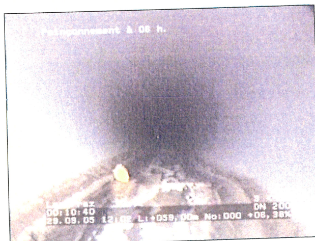
Photo: 2_9a, N° cassette: 1, 00:10:39 59m, Poinçonnement à 06 h.
