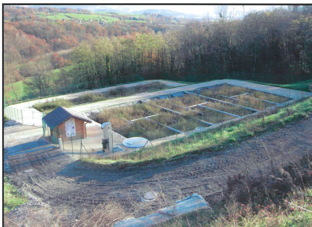
La station dans son ensemble, comprenant le dégrilleur et les 2 étages de lits à macrophytes
