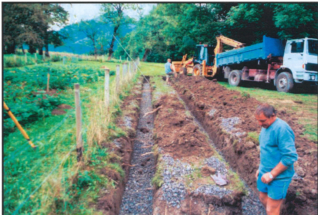
Tranchées d'épandage en cours de réalisation
