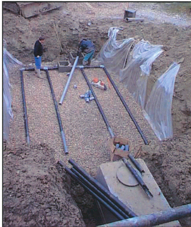
Filtre à sable vertical drainé en cours de réalisation
