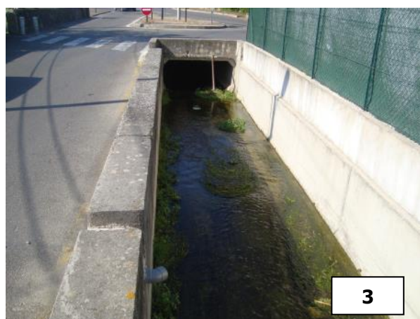
Figure 22 : Localisation et photographies de la zone 1
