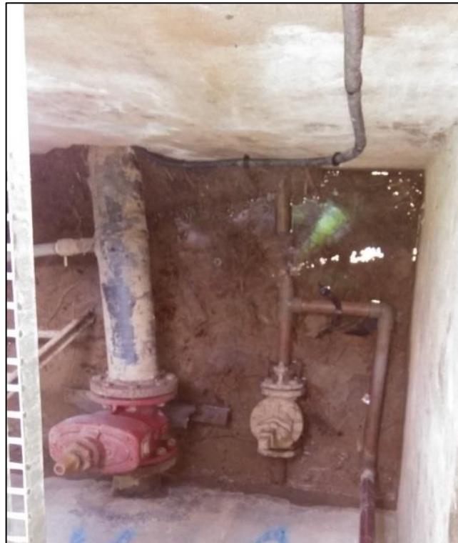
Photo 16 : Intérieur du réservoir des Villarons
