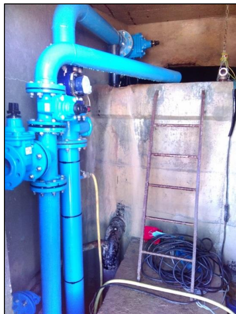
Photo 4 : Intérieur du réservoir de Céüze
