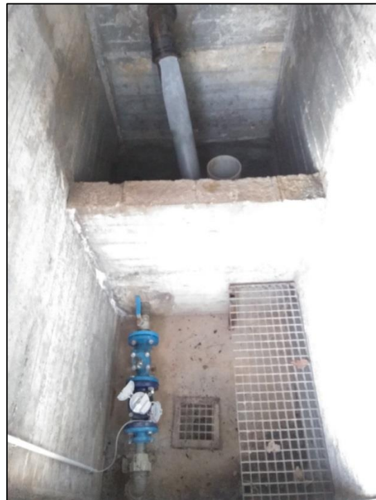
Photo 8 : Intérieur du brise-charge de la Montagne
