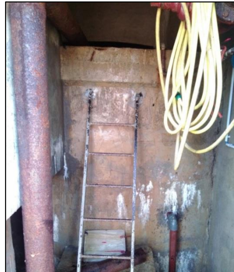
Photo 12 : Intérieur du réservoir des 5 Fets
