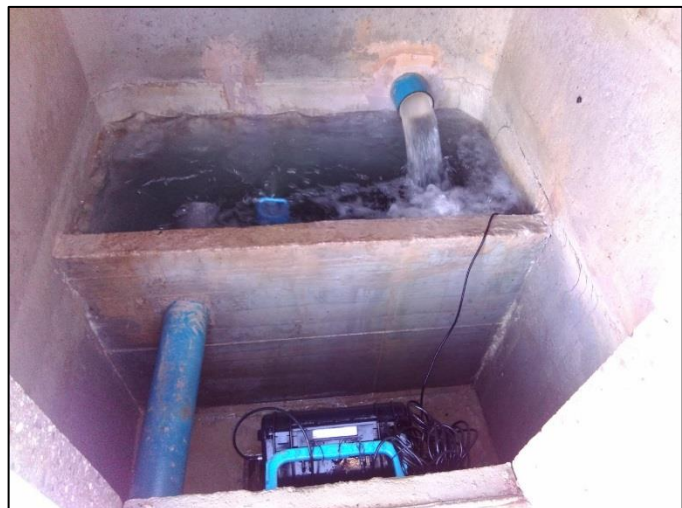
Photo 2 : Intérieur du captage de Miane
