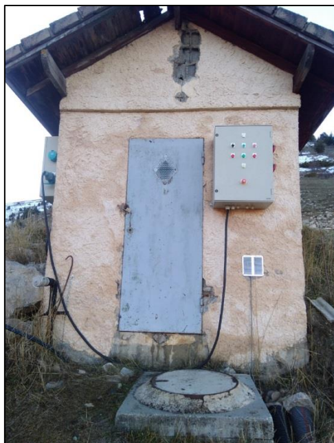
Photo 3 : Réservoir de Céüze
