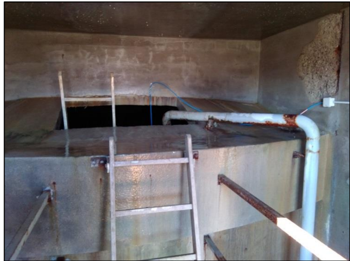
Photo 10 : Intérieur du réservoir des Fets
