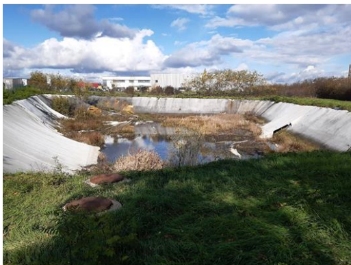
Emplacement BO Les Rutiaux (a2)
