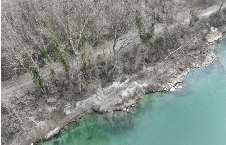
Photo 3-52 : PK17.5 ; source : setec hydratec, drone, 02/2024
