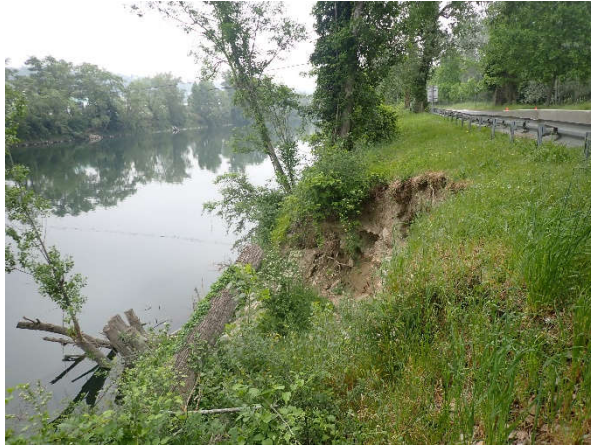
Photo 3-17 : PK14.35 ; source : setec hydratec, septembre 2023
