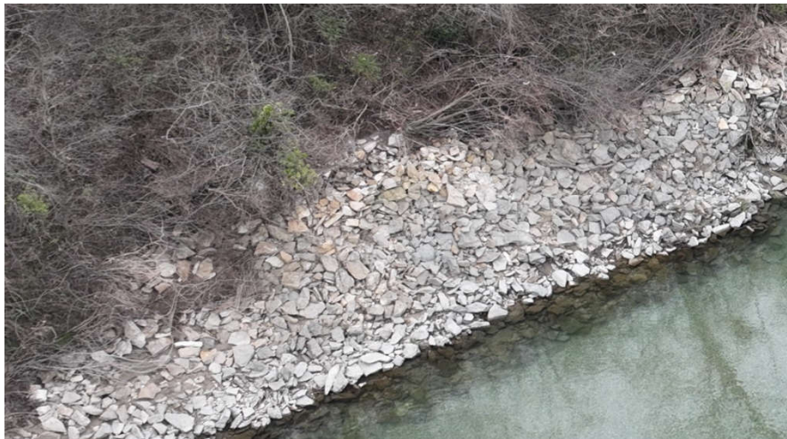
Photo 3-22 : zoom sur protection de berges
