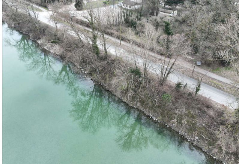
Photo 3-30 : PK14.85 et aval
