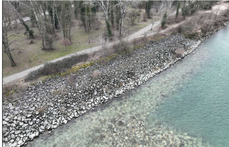
Photo 3-45 : aval immédiat du seuil PK14
