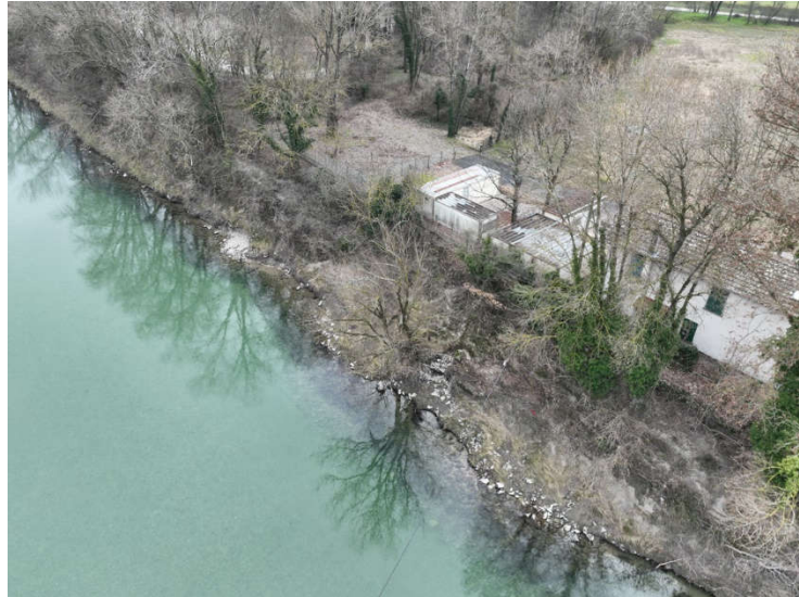
Photo 3-5 : Bâtiment Le Cabanon, PK16.4 environ
