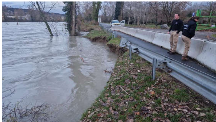
Photo 3-36 : PK14.52 - 18/12/2023 ; source : Segapal
