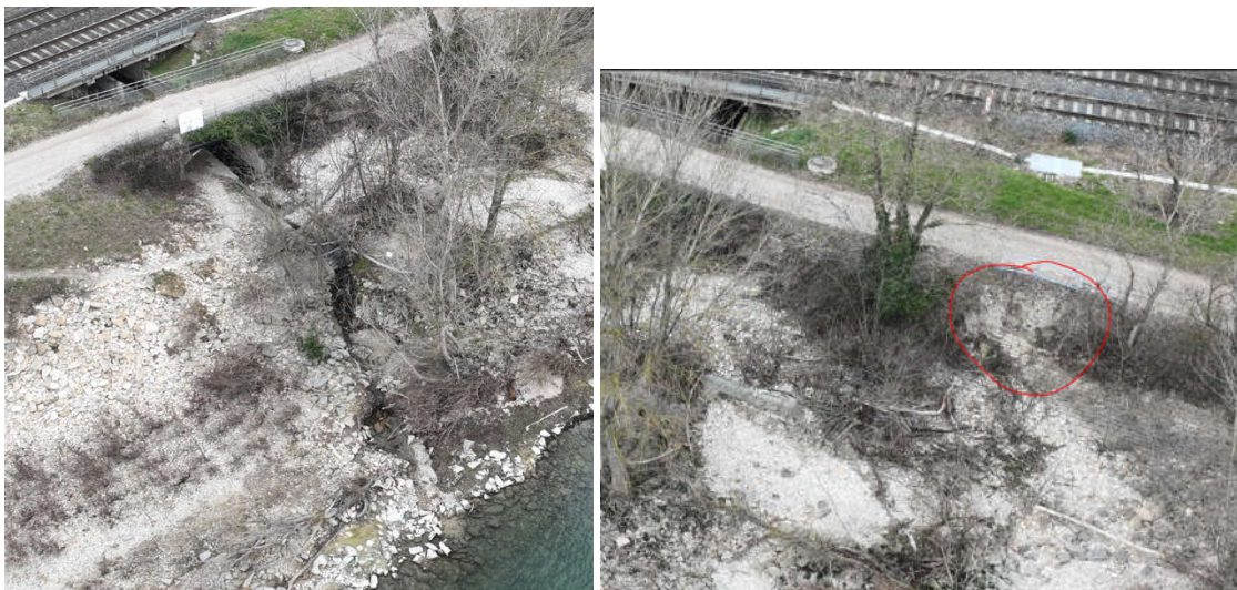
Photo 3-78 : exutoire ruisseau du Molliet
