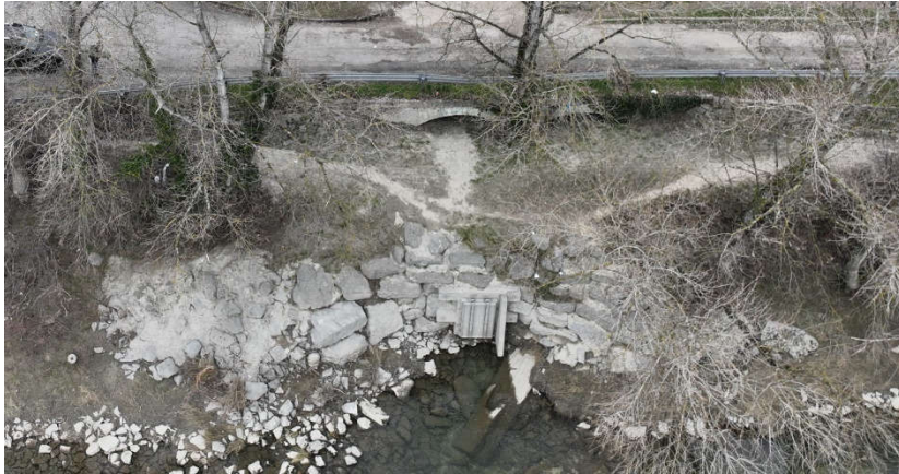
Photo 3-54 : exutoire EP PK16.95
