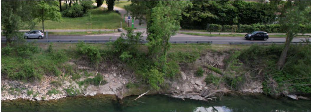
Photo 3-35 : PK14.52 ; mai 2022 ; source : Symalim
