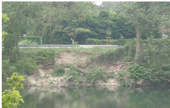
Photo 3-15 : PK14.55 source : setec hydratec, mai 2023
