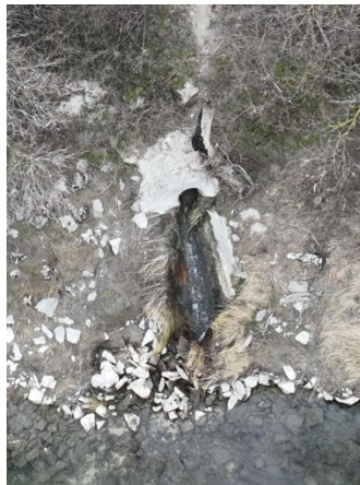
Photo 3-53 : exutoire EP PK17.2 environ
