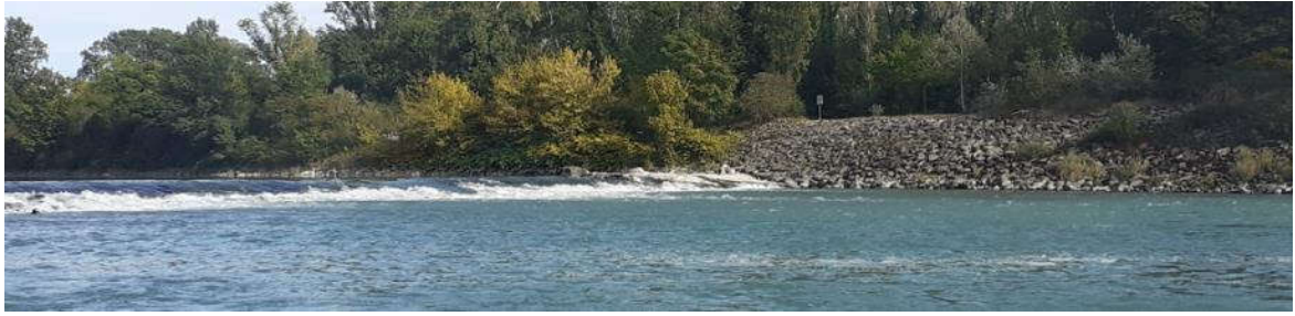
Photo 9-4 : seuil PK14 – RG
