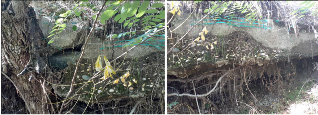
Photo 9-2 : réseau en encorbellement – pont Molliet PK13.78
