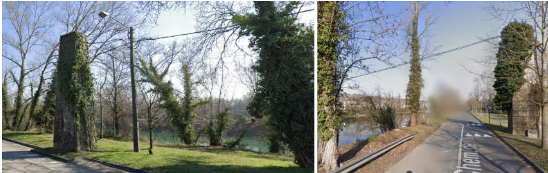
Photo 6-1 : bac à traile en RD (gauche) et RG (droite) – PK14.55
