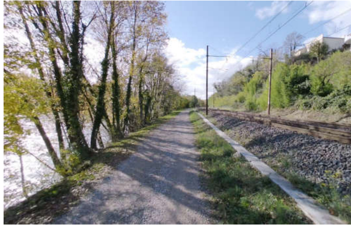
Photo 5-14 : chemin de halage + voie ferrée – PK13.4
