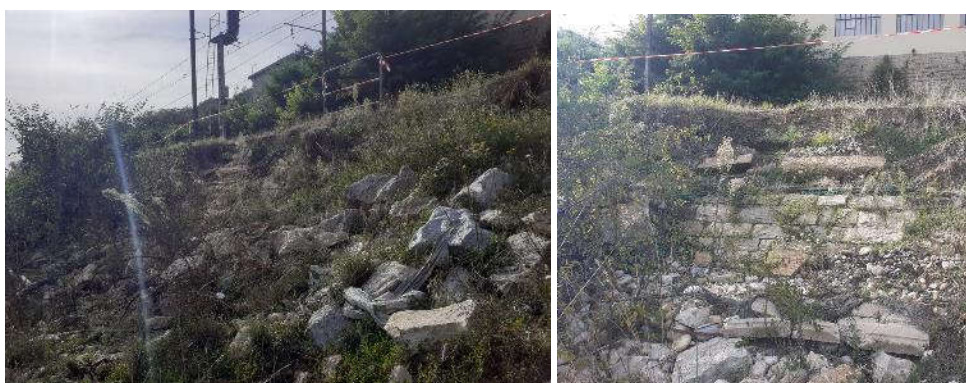
Photo 8-3 : perré maçonné + blocs d'apport sur géotextile sur perré – blocs béton armé épars ; source : setec hydratec 09/2023
