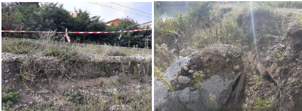
Photo 8-2 : gauche : perré maçonné ; droite : blocs d'apport sur géotextile sur perré ; source : setec hydratec 09/2023
