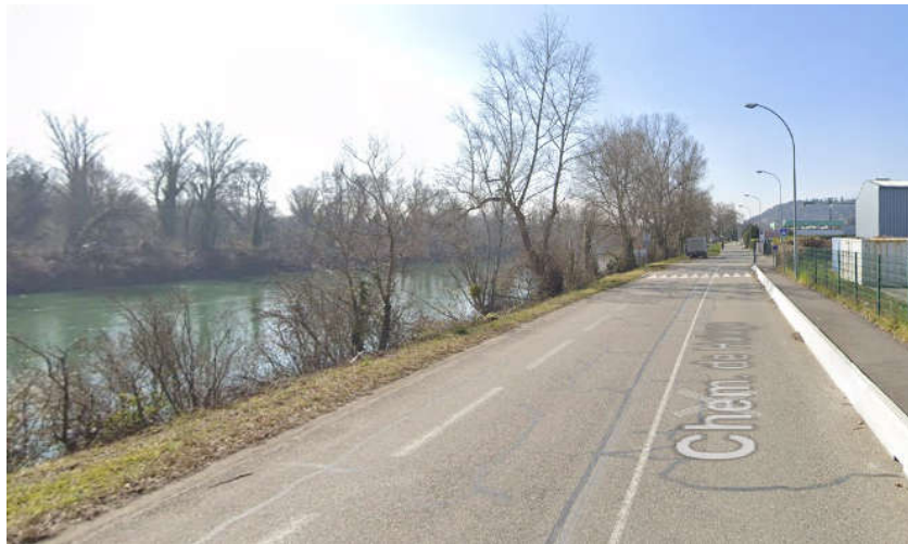
Photo 5-10 : chemin de halage RD
