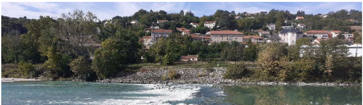
Photo 9-3 : seuil PK14 – RD
