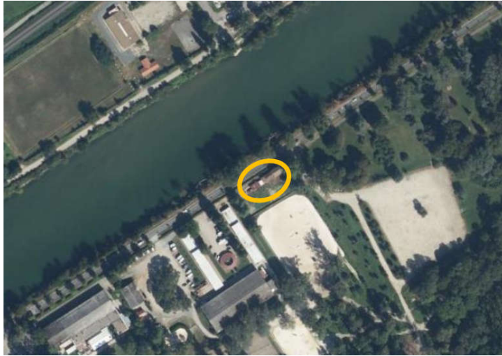
Photo 5-7 : bâtiment sans usage, étude de sa démolition en cours
