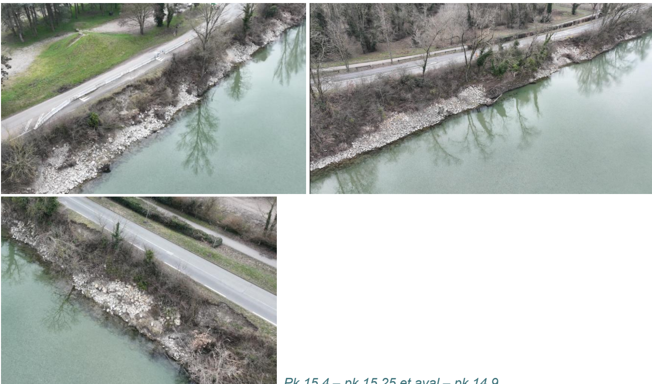
Pk 15.4 – pk 15.25 et aval – pk 14.9
