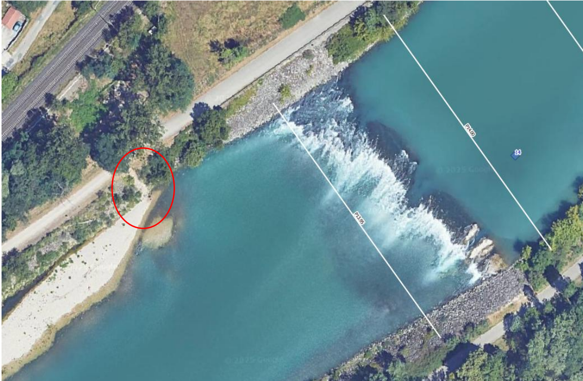
Figure III-1 : Position du désordre PK13.85
