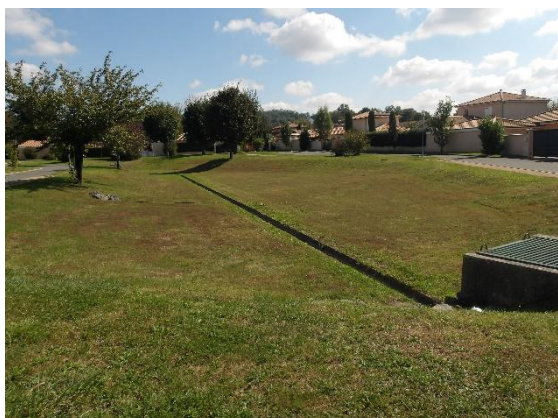
Bassin de rétention des eaux pluviales sur le Bief du Temps
