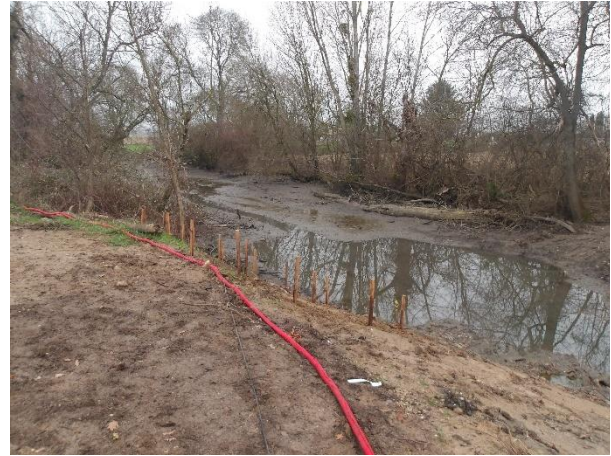
Aménagement en cours sur l'ancienne retenue
