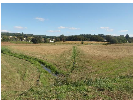
Bassin tampon excréteur de crue avec ouvrage de régulation en aval sur le ruisseau de Veissieux
