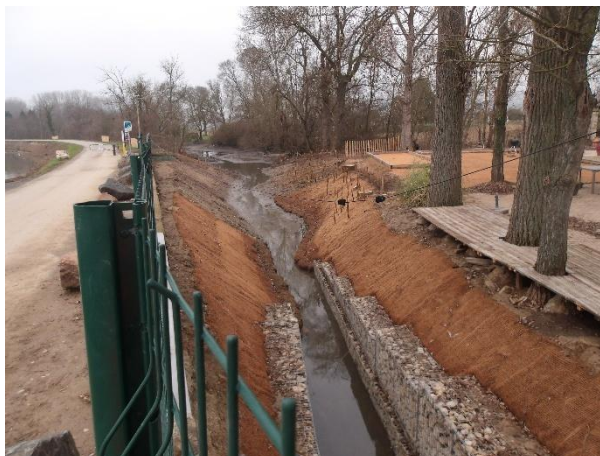
Aménagement de l'ancien ouvrage
