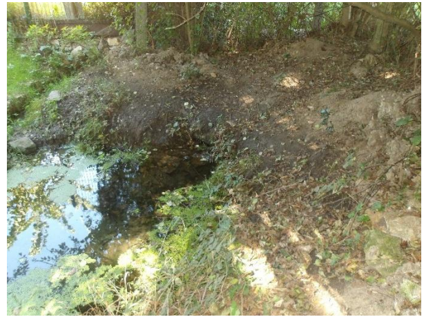
Arrivée d'eaux pluviales vers la mare
