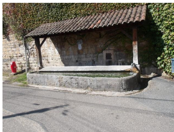
Lavoir en amont de Fontaine Bénite
