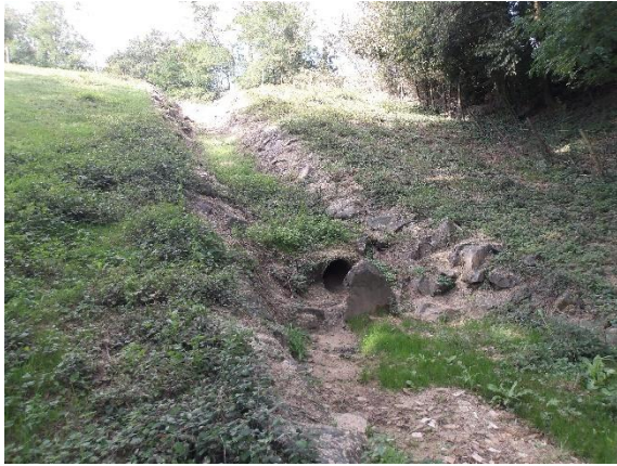
Présence d'ouvrage de régulation hydraulique sur le ruisseau de Champ Perrier altérant la continuité écologique
