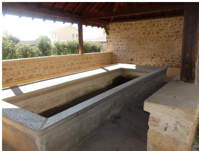
Figure 33 : Lavoire restaurée au bord du ru du Veissieux
