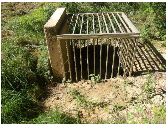
Ouvrage de régulation hydraulique sur le ruisseau de Bessey
