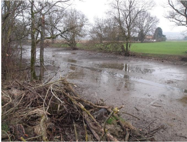
Aménagement en cours sur l'ancienne retenue
