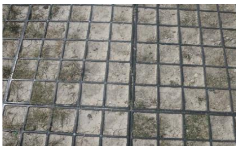
Figure 45 : dalle en PEHD colmatée
