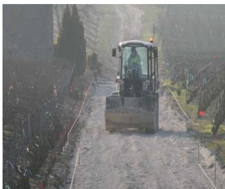
Figure 46 : terrassement et préparation du fond de forme
