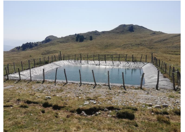
Goya Sac Ecorans sous Crêt de la Goutte (250 m3)
