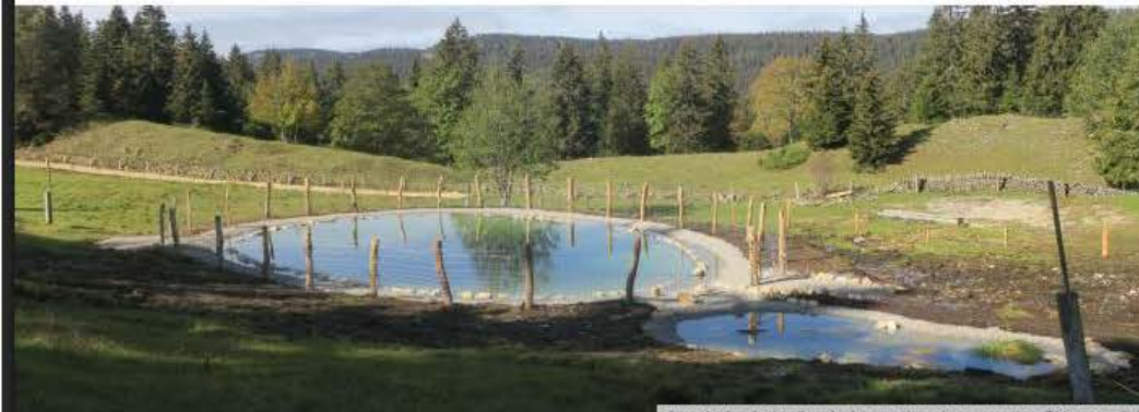
Étang de récupération d'eau de pluie avec étang de compensation - ©Montanum Sàrl
