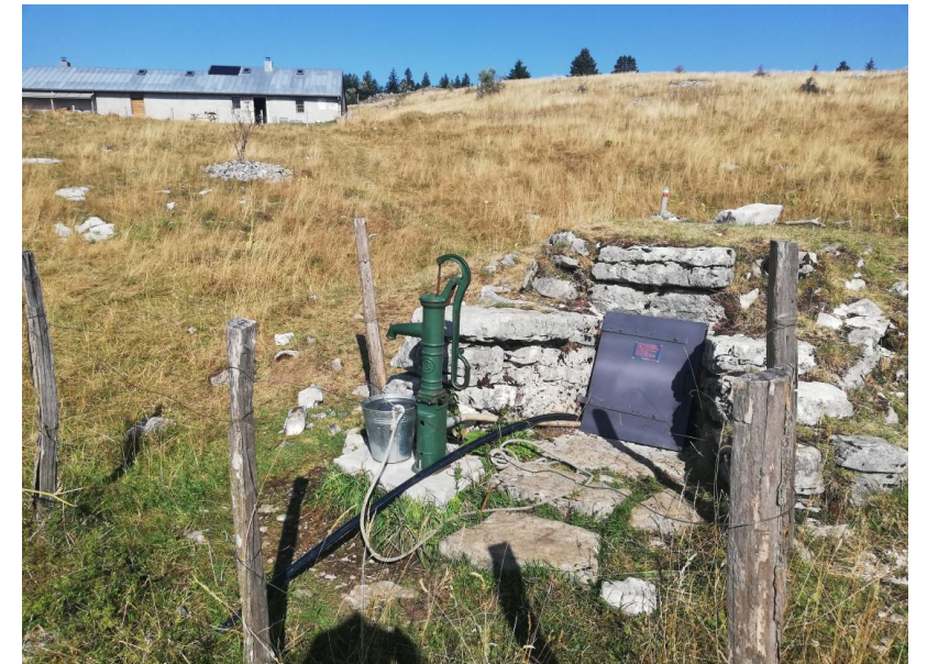
citerne enterrée 30 m 3
