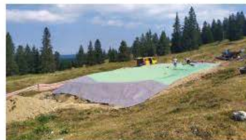
e. Imperméabilité (bâche entre deux géotextiles)
