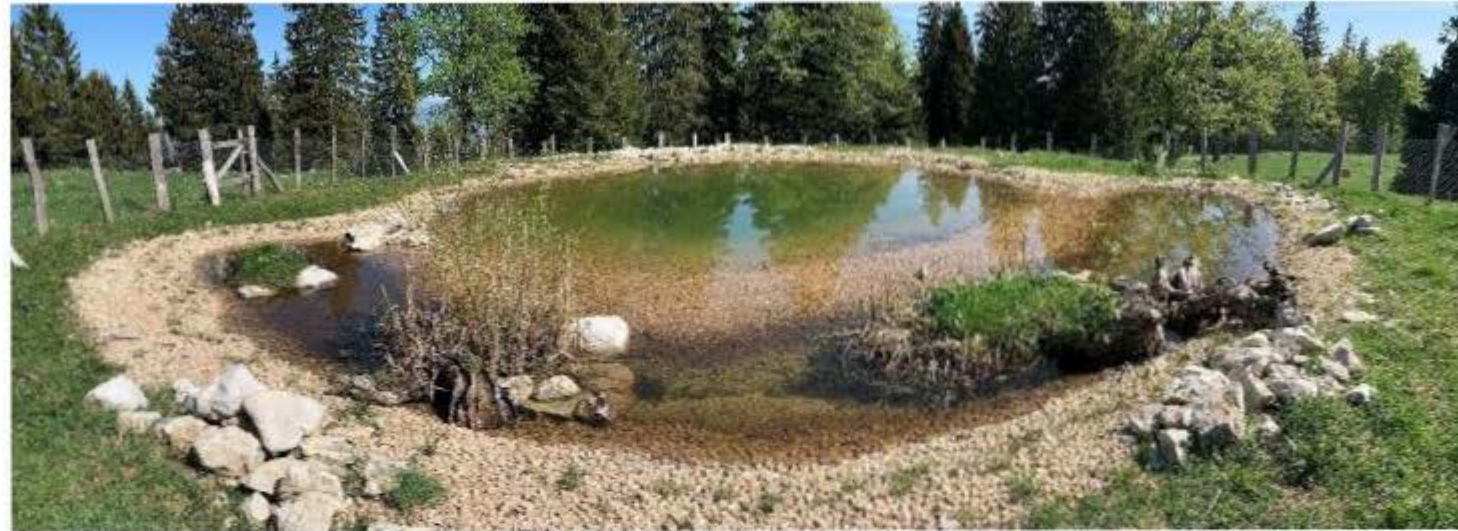
Figure 1. L'étang agroécologique de la Correntine (Bière, VD) six ans après sa construction. D'une capacité de rétention de 150 m 3 , il sécurise l'approvisionnement en eau de deux alpages voisins. Il accueille par ailleurs une diversité biologique remarquable à l'échelle régionale (flore, batraciens et libellules).
