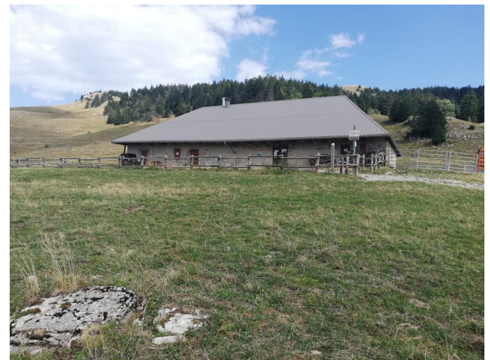
Citerne enterrée bâtiment - 30 m 3
